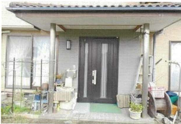
玄関付近の状況
