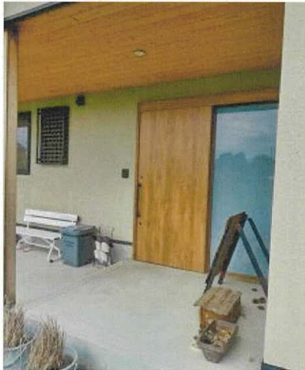
エントランスの状況
