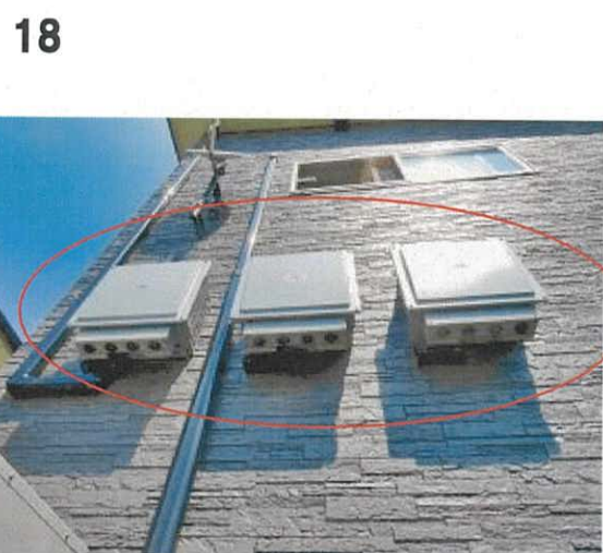
PVユニットの設置状況
