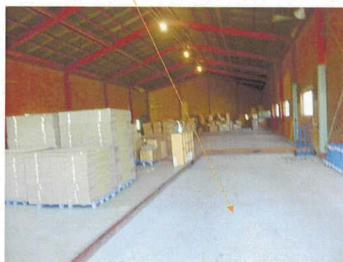
⑥ 物件5 内部 土間コンクリート
