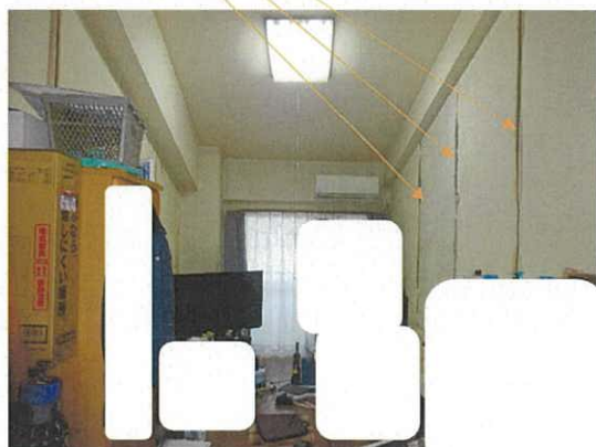
59 壁クロス損傷
