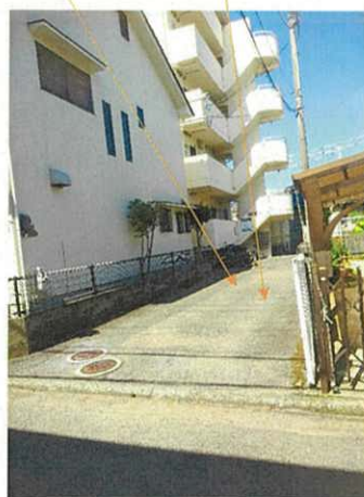
② 物件1 駐車場部分
