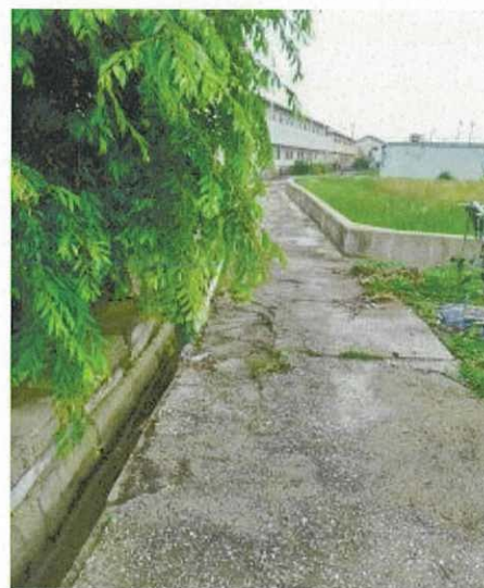
北側道路の状況
