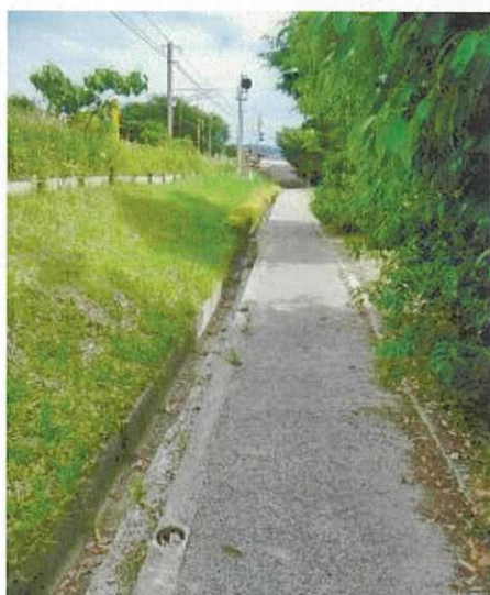
東側道路の状況
