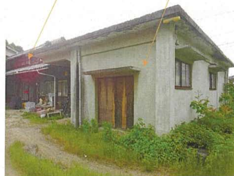
物件 4 主たる建物 未登記増築部分
