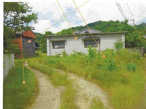
物件 4 主たる建物未登記増築部分 物件 5 物件 3 物件 4 附属建物符号 1
