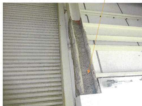
物件2 内部 1階 吹付部分
