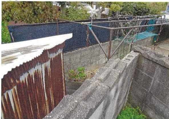
13 (北西側の囲障の状況①)
