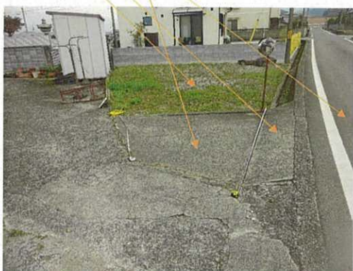
① 物件1 同西端コンクリート敷部分 水路上の床版橋 市道
