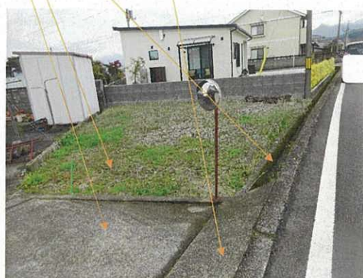
③ 物件1 水路 床版橋
