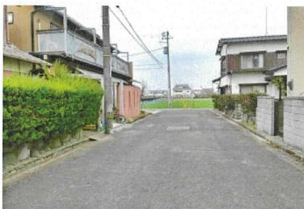
接面道路の状況
