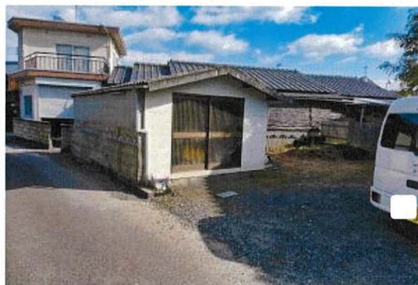
附属建物の状況
