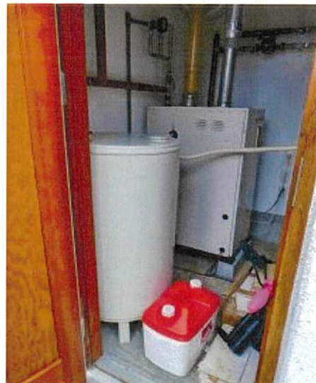
ボイラー室の状況
