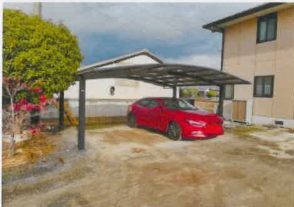
カーポートの状況
