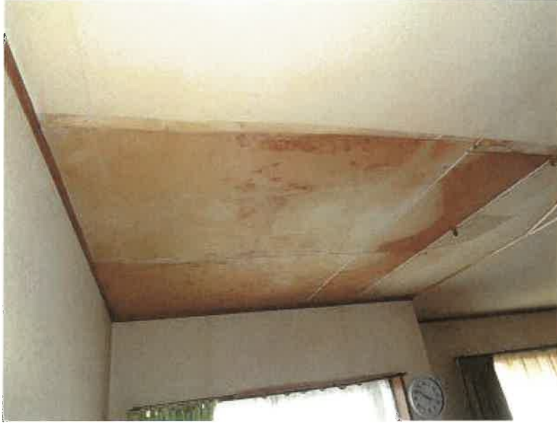
1階 リビングダイニングキッチンの天井の状況
