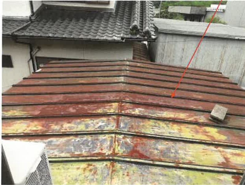
物件 2 の建物（屋根の状況）
