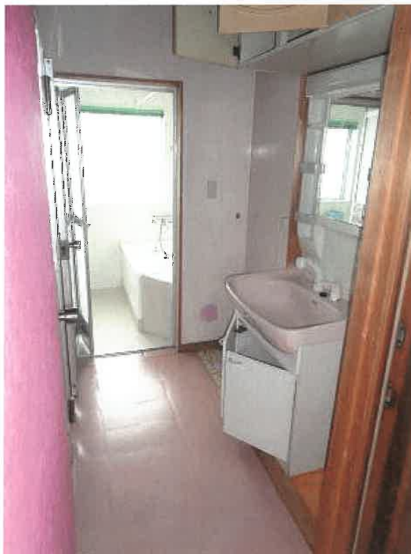
物件4 2階洗面脱衣室
