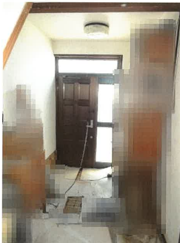
物件2の建物（1階玄関内）の状況
