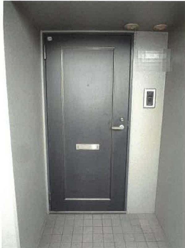
203号室（玄関）の状況
