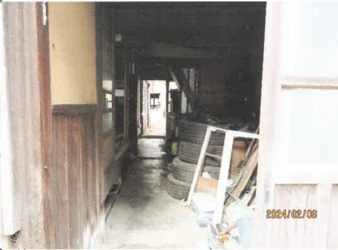
物件2 玄関付近
