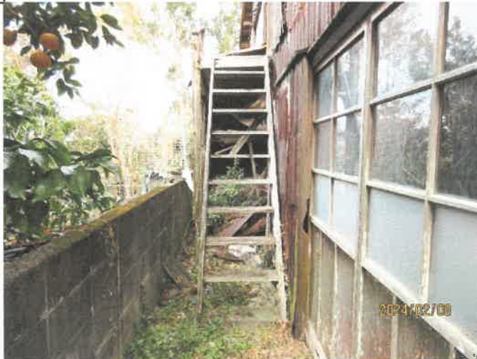
物件3 1階から2階への外階段
