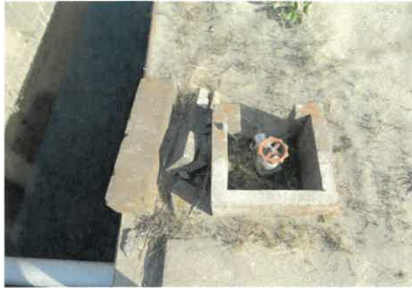
(西端付近に存在する給水栓)
