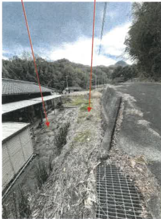
物件1 北西側の状況
