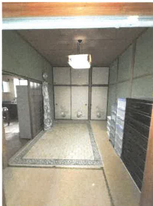
物件2 北側和室の状況
