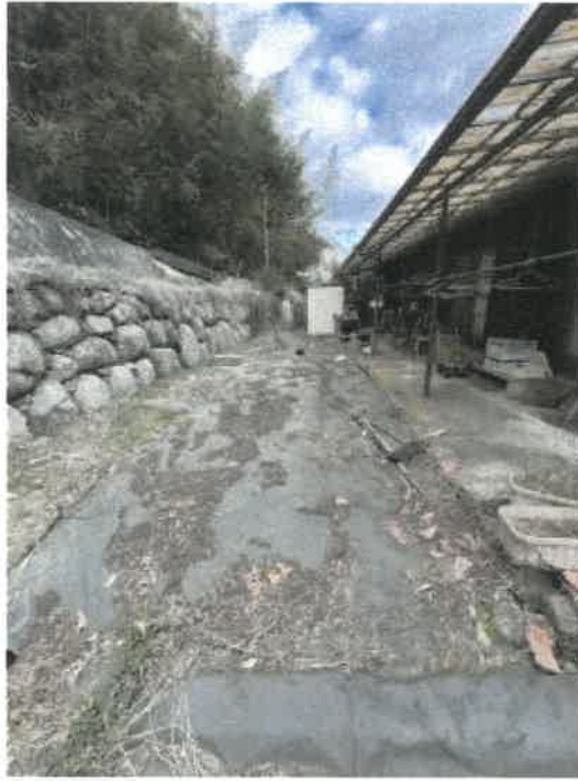
物件1 南西側の状況
