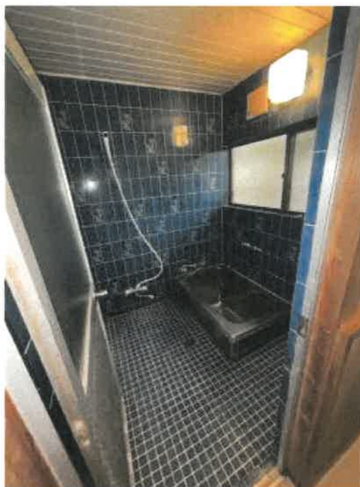
物件 2 浴室の状況
