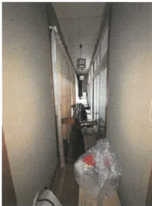
物件2 南東側廊下の状況
