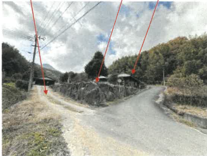
物件 1 北東側の状況
