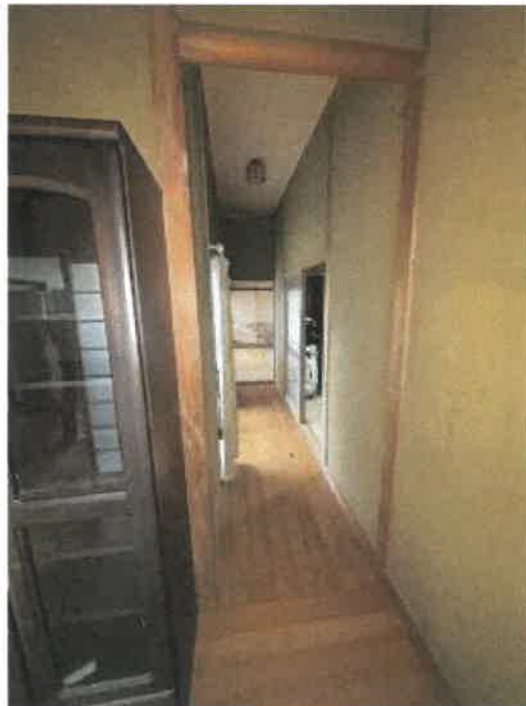
物件 2 北西側廊下の状況
