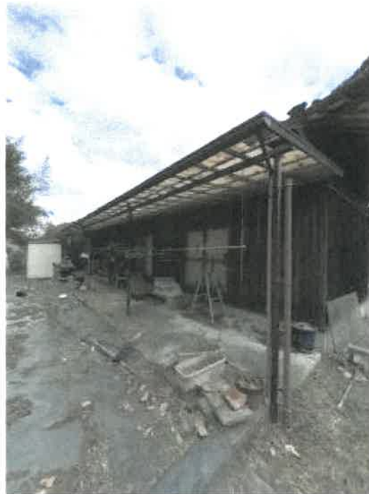
物件2 南西側の状況
