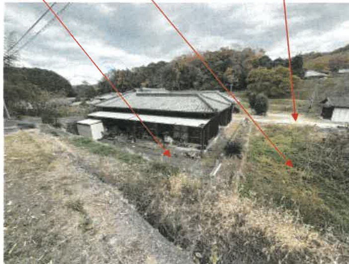
物件1 南西側の状況
