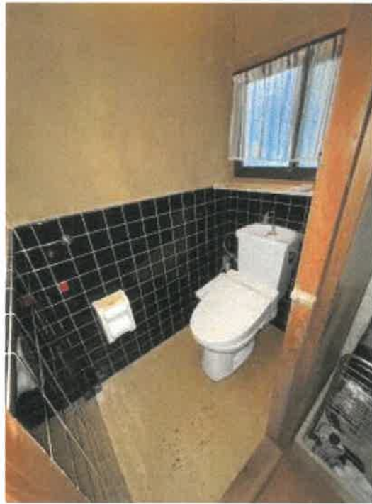
物件 2 トイレの状況
