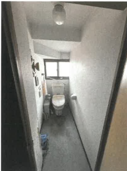
物件2 主建物1階トイレの状況
