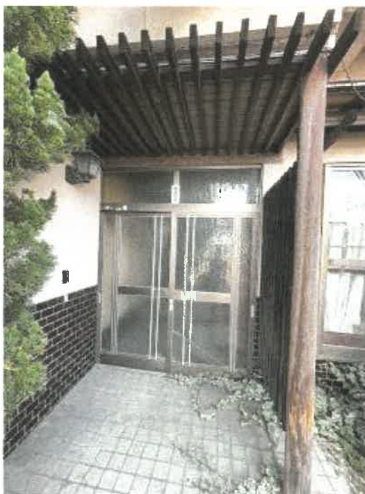
物件2 主建物玄関付近の状況
