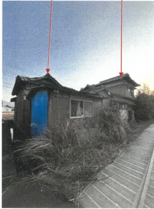
物件 1 北東側の状況
