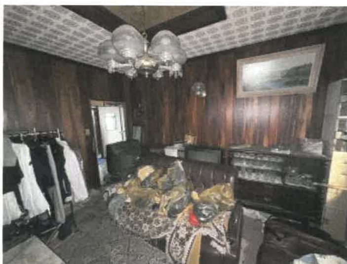
物件2 主建物1階洋室の状況
