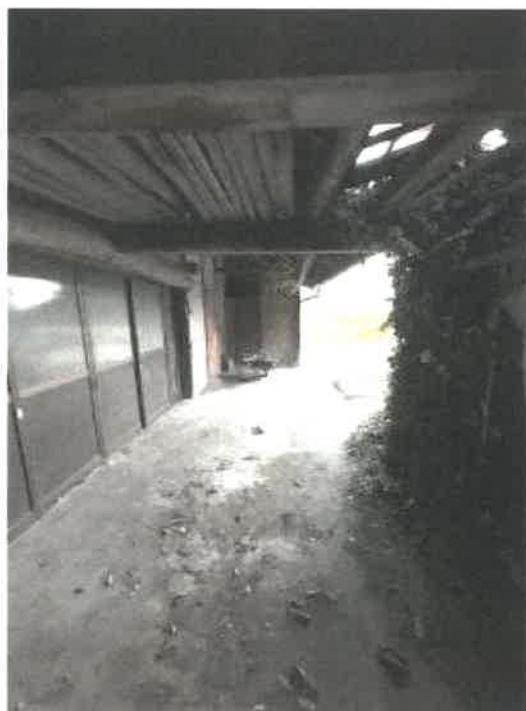
物件 2 主建物増築部分（物置）の状況
