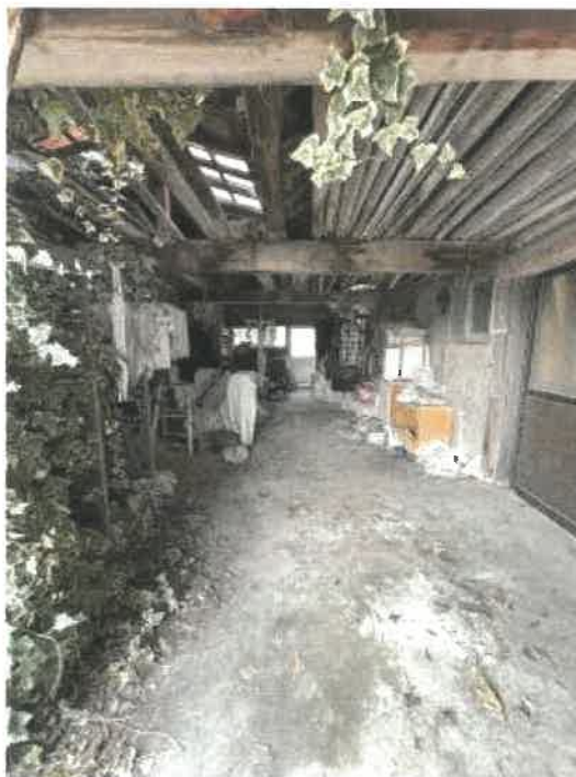
物件2 主建物増築部分（物置）の状況
