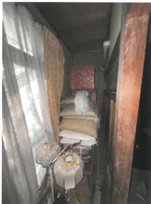
物件2 主建物1階縁側の状況
