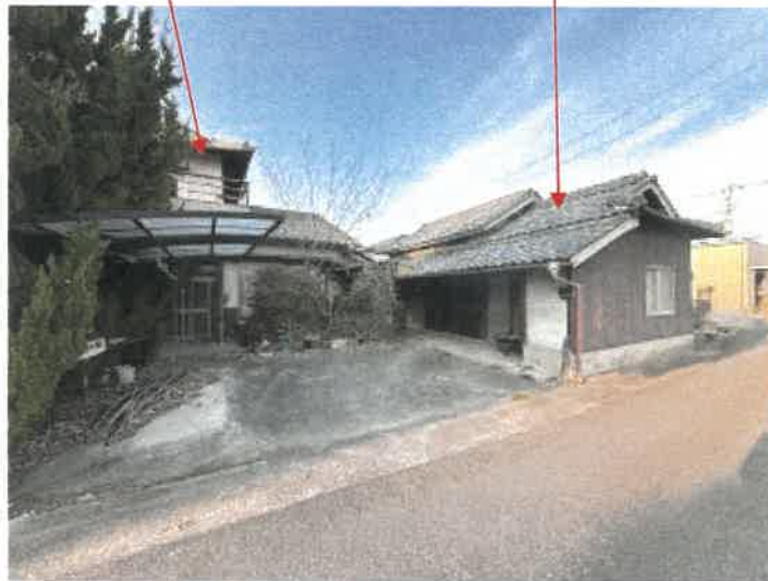
物件 1 南側の状況
