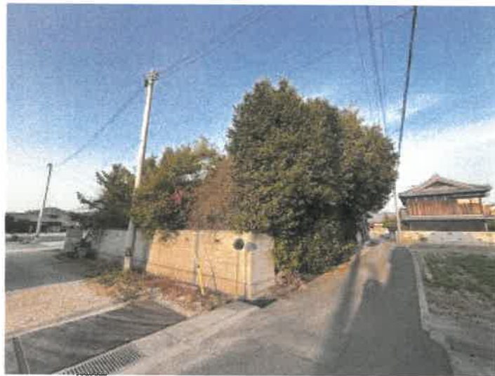
物件1 南西側の状況
