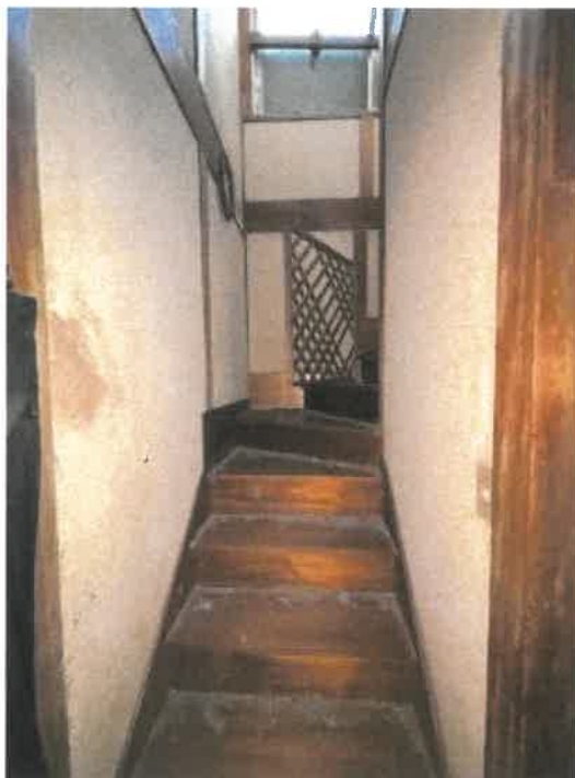
物件2 主建物階段の状況
