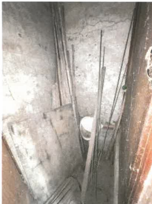
物件 2 未登記附属建物トイレの状況
