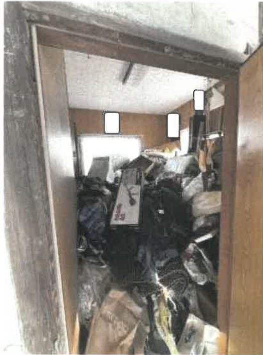
物件 2 未登記附属建物洋室の状況
