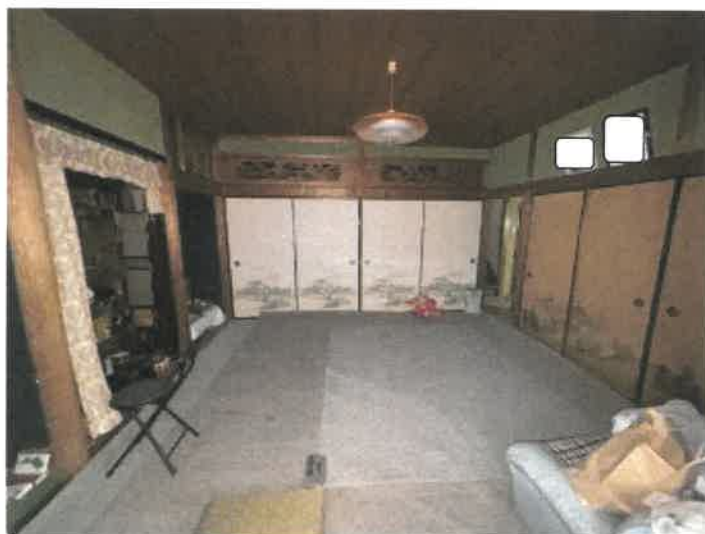
物件2 主建物1階南西側和室の状況
