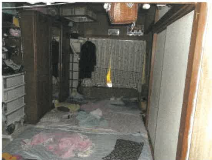
物件 2 建物の 2 階ほぼ西側和室の状況
