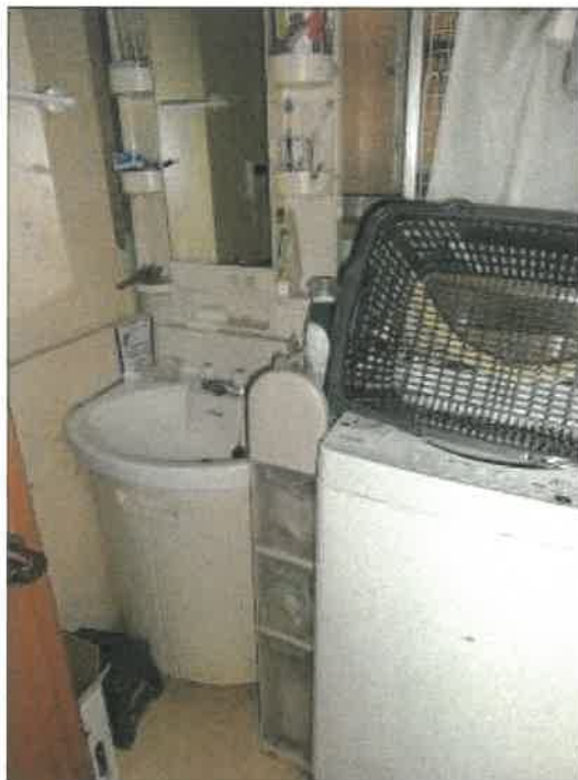
物件 2 建物の 1 階洗面脱衣所の状況
