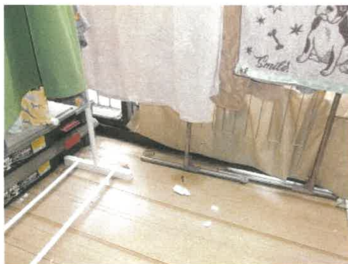
物件 2 建物の 2 階ほぼ東側洋室ほぼ南側のベランダの状況
