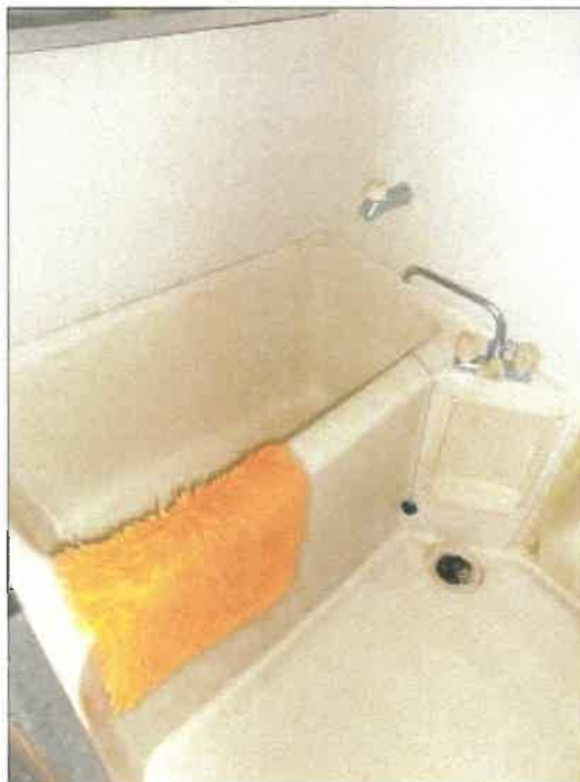
物件 2 建物の 1 階浴室の状況
