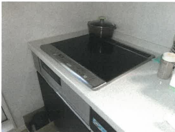
物件1 建物のキッチンのIHクッキングヒーターの状況
