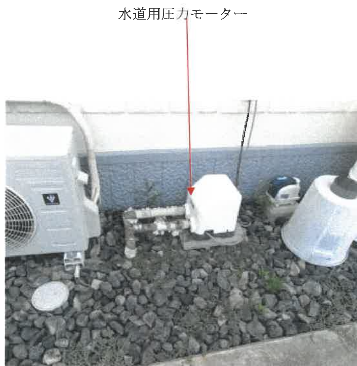
物件 1 建物西側の状況
