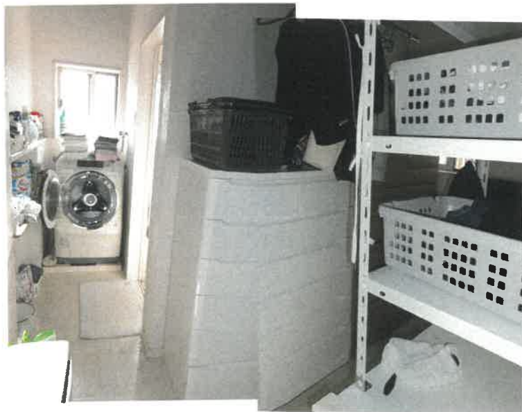
物件1 建物の1階洗面脱衣所の状況
