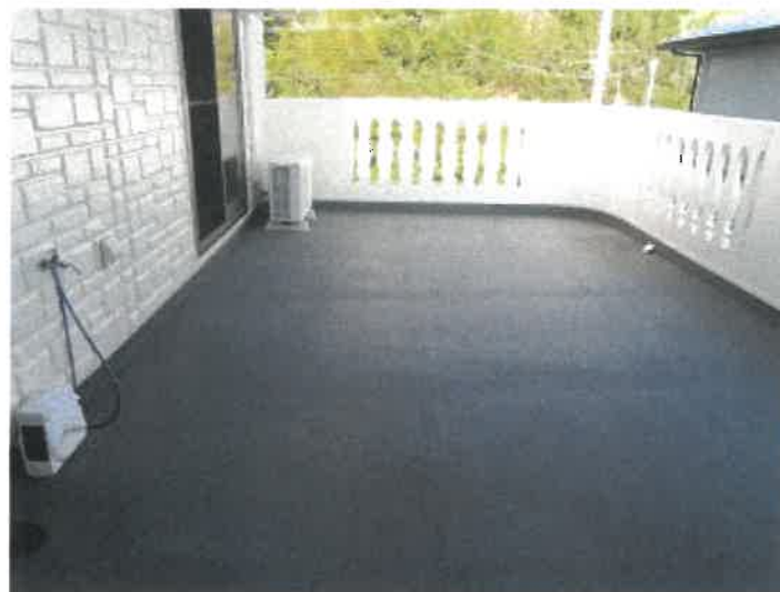
物件 1 建物の 2 階バルコニーの状況
