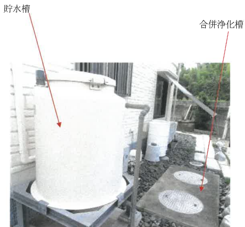
物件 1 建物西側の状況
