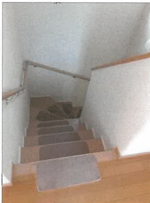
物件 1 建物の階段の状況
