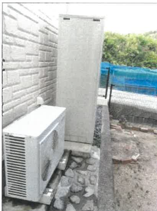
物件1 建物北西側のエコキュートの状況
