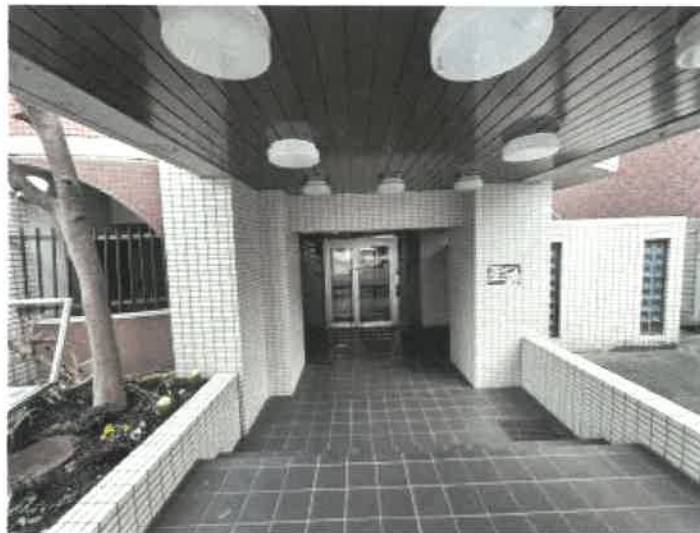
マンション入口付近の状況
