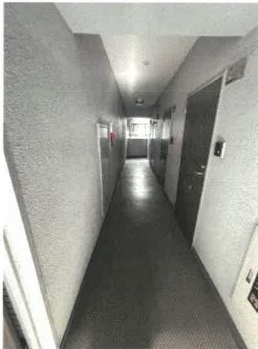
103号室前の通路の状況
