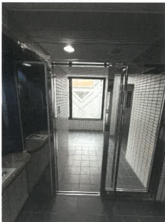
玄関ホールの状況
