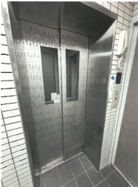
エレベータ付近の状況
