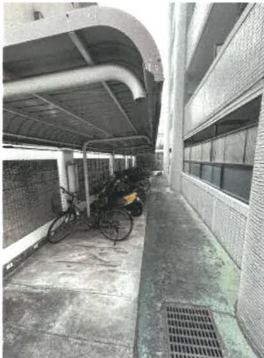
東側駐輪場の状況
