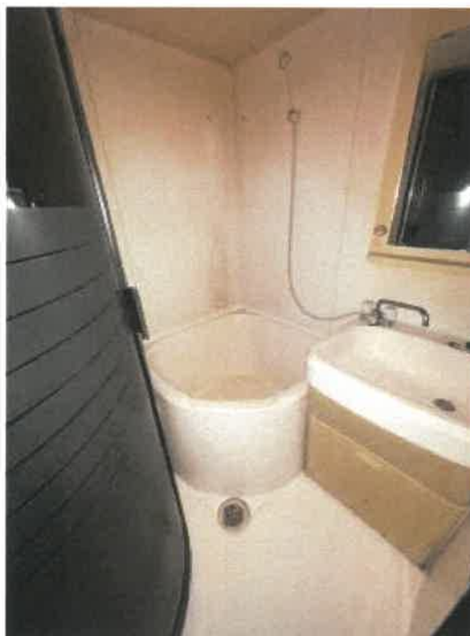
ユニットバスの状況
