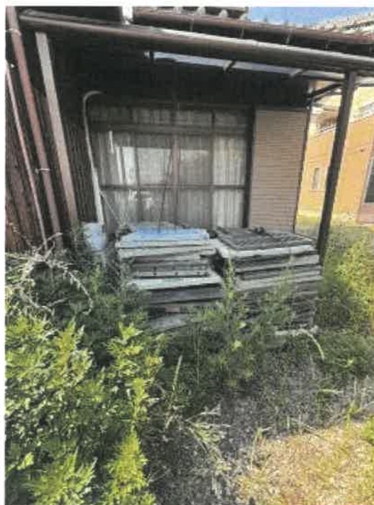
物件2 南東側付近の状況
