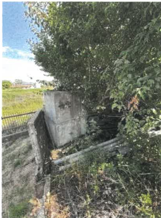
本件物件南東側の状況
