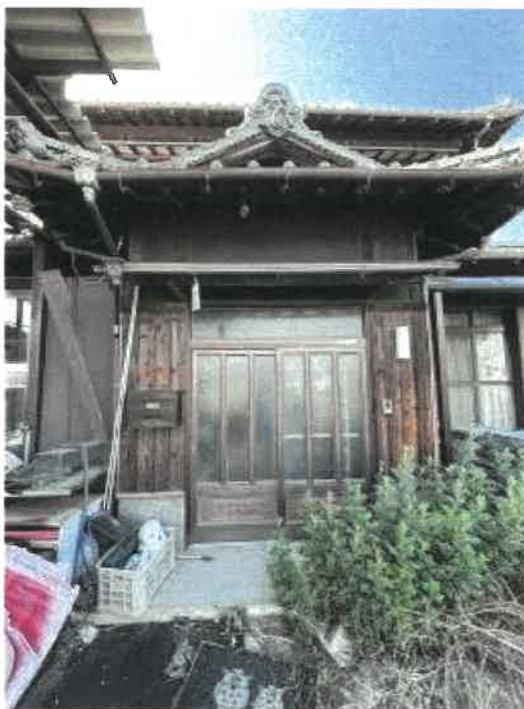
物件2 玄関付近の状況
