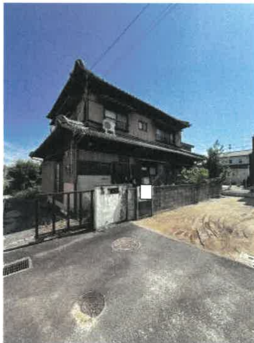
本件物件の北東側の状況
