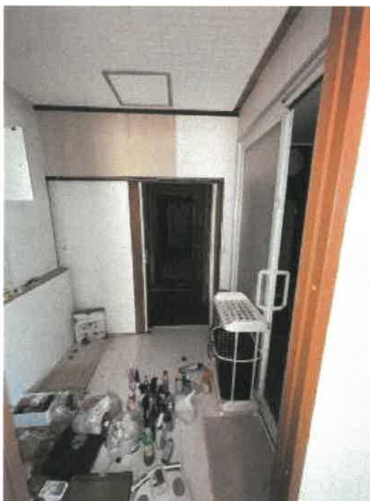
物件2 1階脱衣所付近の状況
