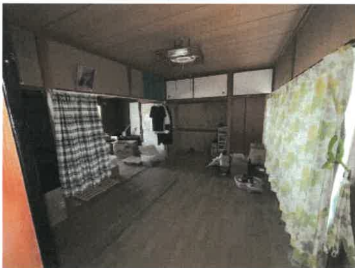
物件 2 2階北西側和室の状況
