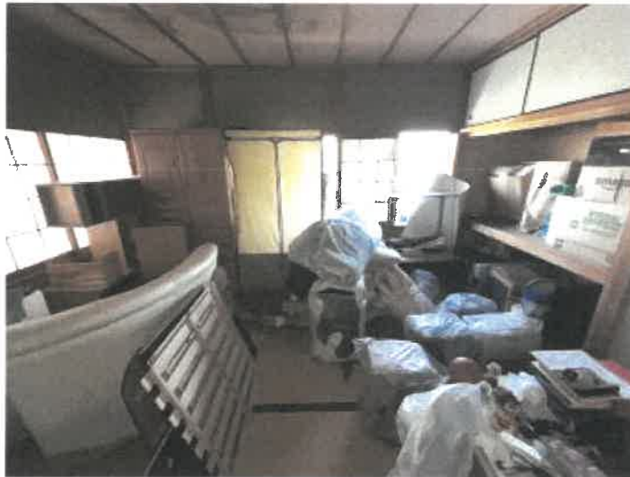
物件 2 2階南東側和室の状況
