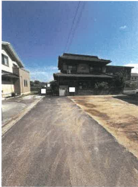
北東側道路の状況
