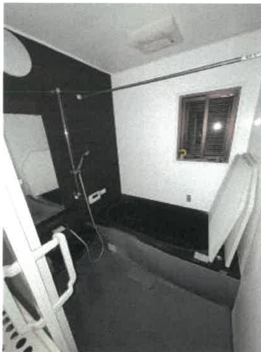
物件2 1階浴室の状況
