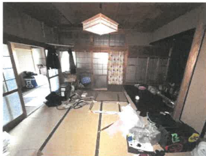
物件2 1階南西側和室の状況
