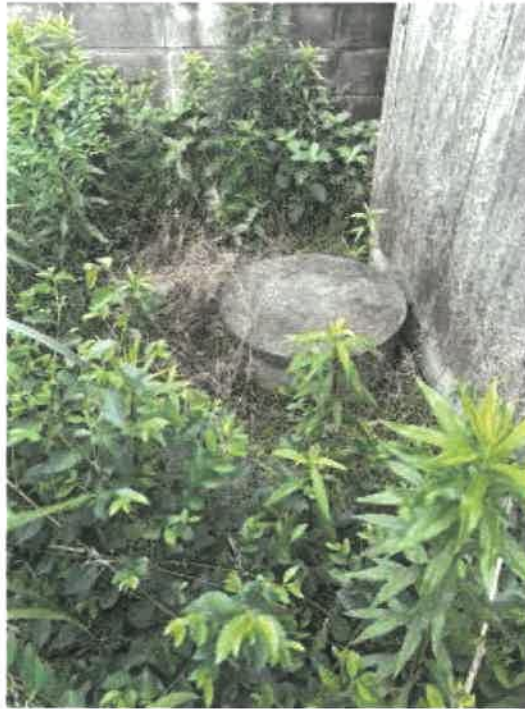
物件 1 南東側の井戸の状況
