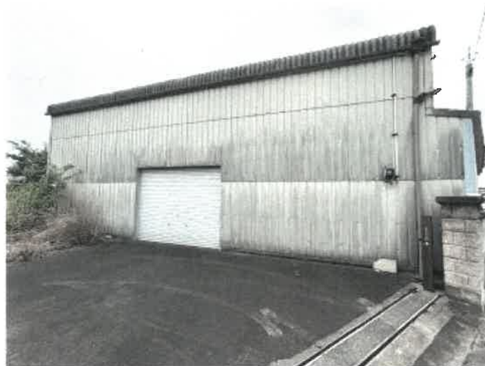
物件 3 倉庫の状況
