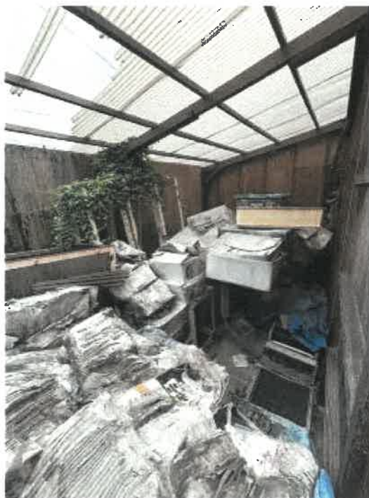
物件 2 南西側物置の内部の状況
