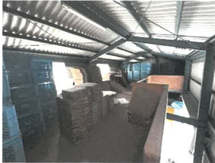
物件3 倉庫屋根裏の状況
