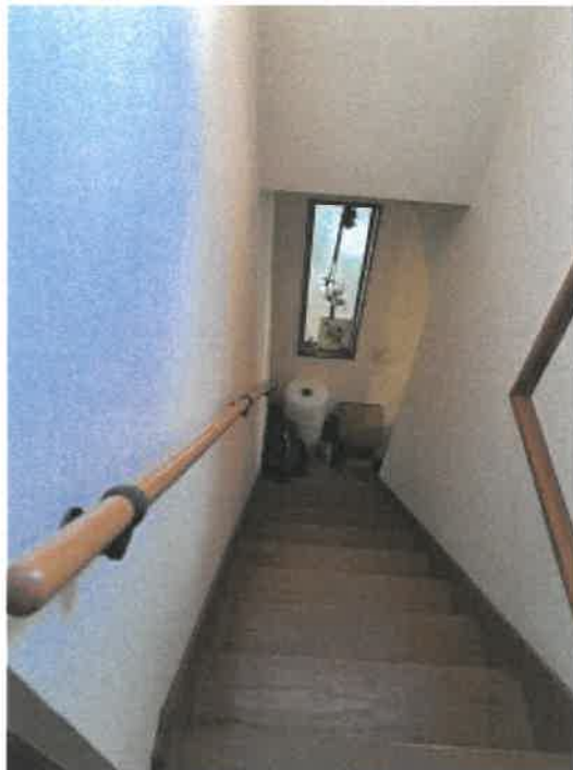
物件 2 建物の階段の状況
