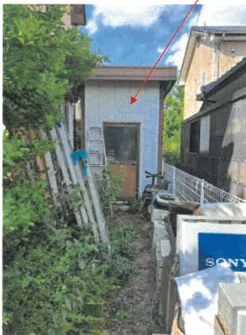
未登記附属建物の状況
