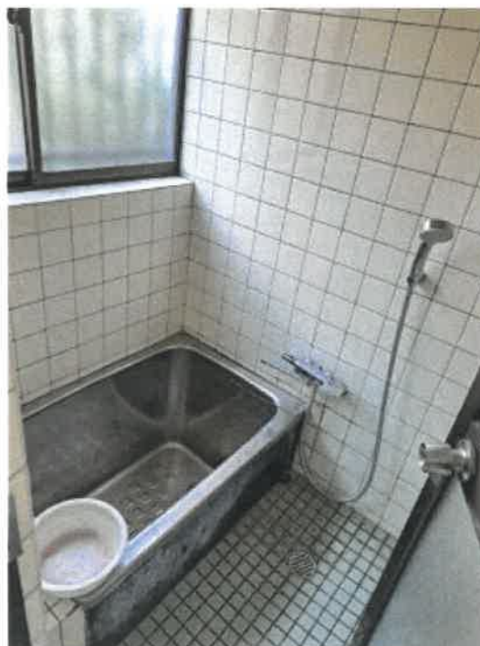
物件 2 建物の 1 階浴室の状況
