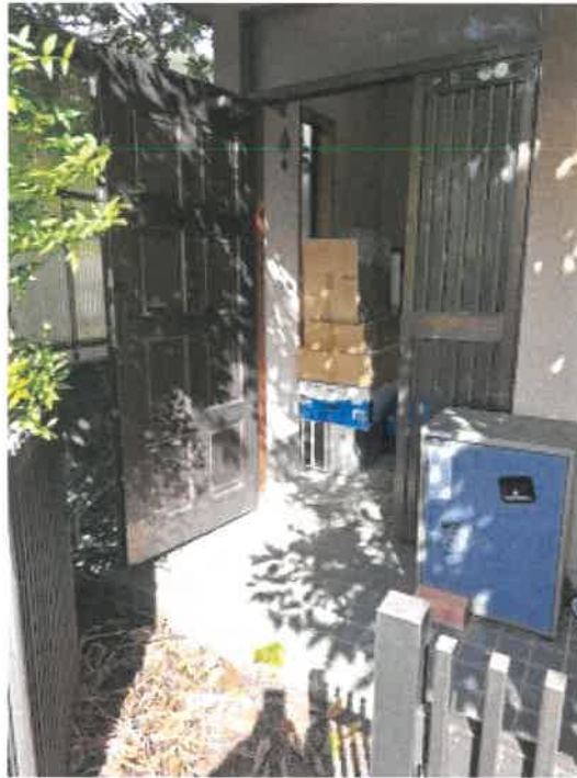
物件2建物玄関周りの状況
