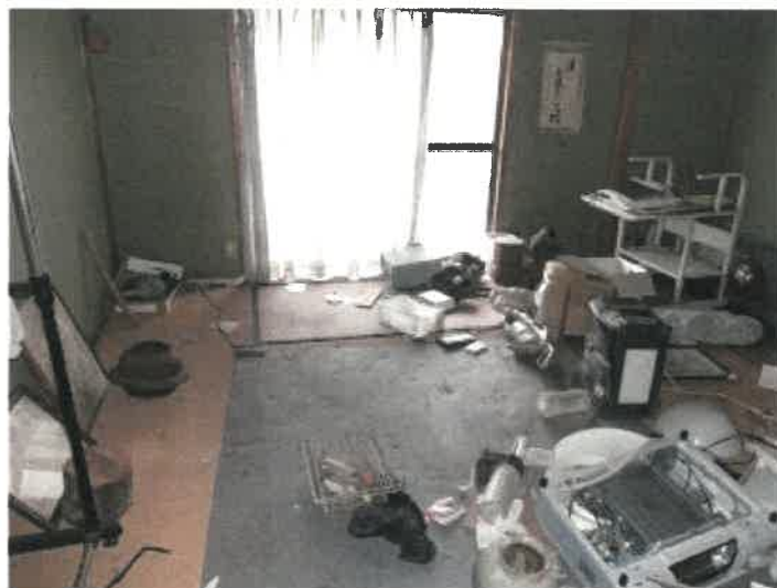
物件 2 建物の元の部分の西端東西廊下南側 2 間南和室の状況
