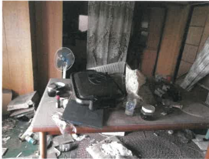
物件 2 建物の元の部分の北東側洋室（台所）付近の状況
