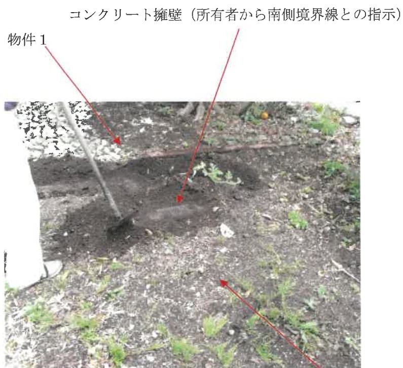
物件 1 土地南側境界線付近の状況
