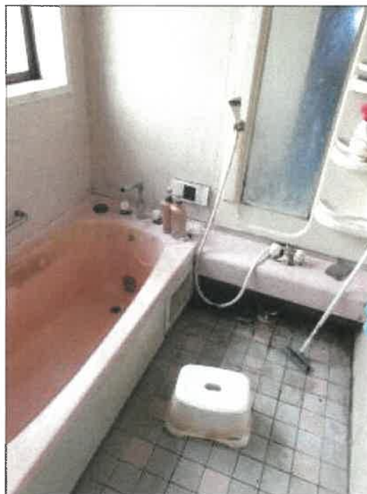
物件 2 建物の増築部分 1 階浴室の状況
