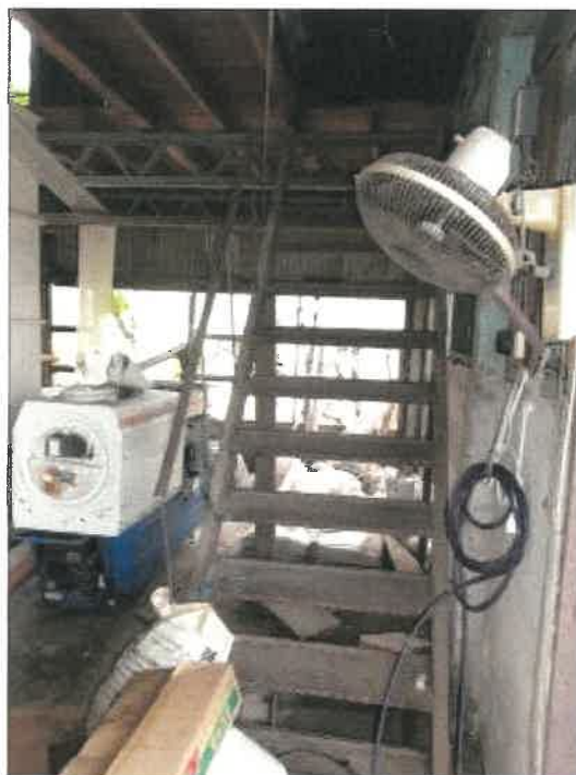
物件 2 建物西側倉庫内の階段の状況
