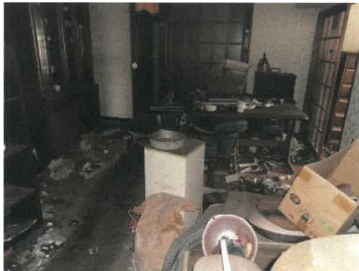
物件 2 建物の元の部分の中央付近の通路状の洋室の状況
