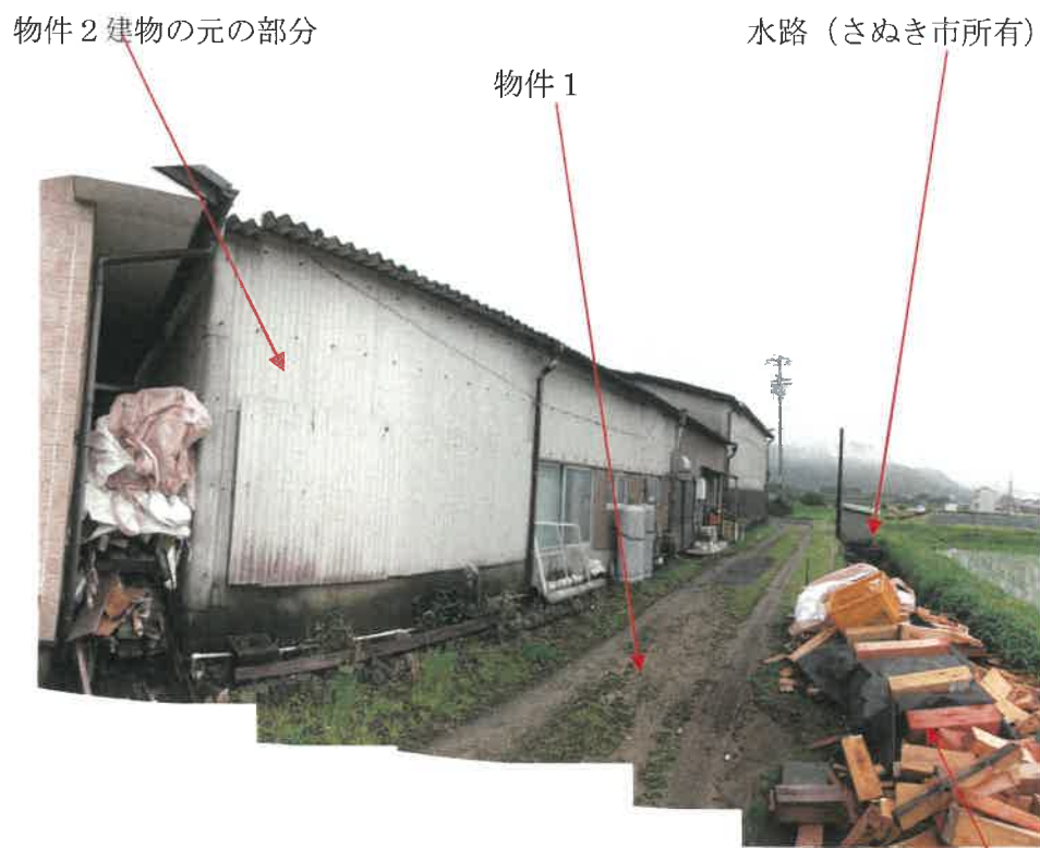
物件1 土地北側境界付近の状況
