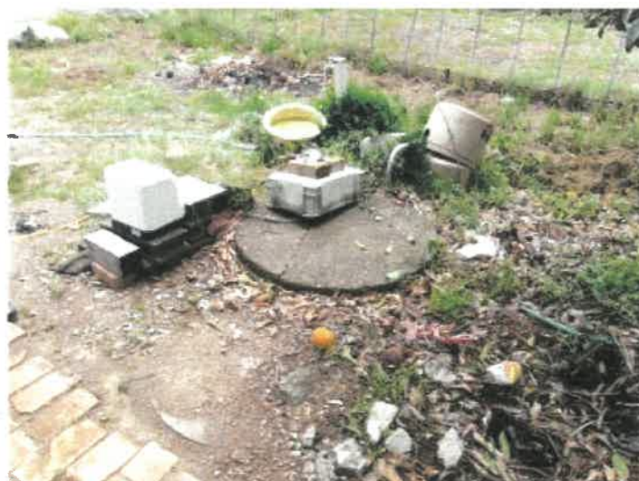
物件 1 土地南東側の井戸の状況
