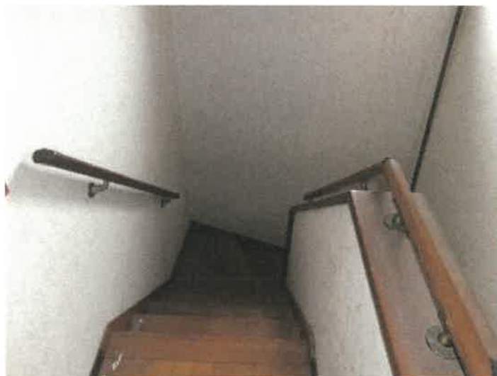
物件2建物の増築部分の階段の状況
