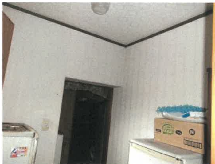
物件2建物の増築部分から元の部分への通路の状況
