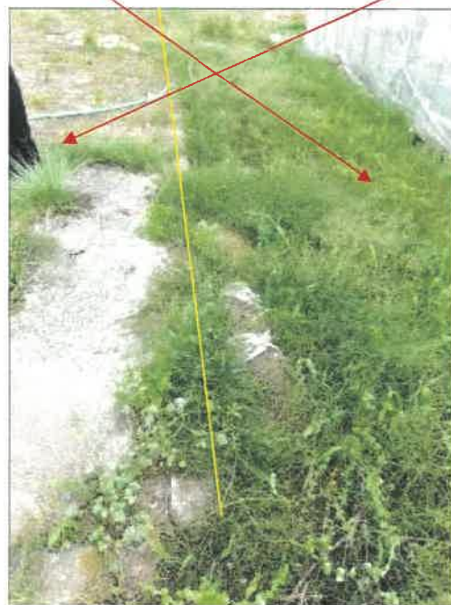
物件 1 土地東側境界付近の状況
