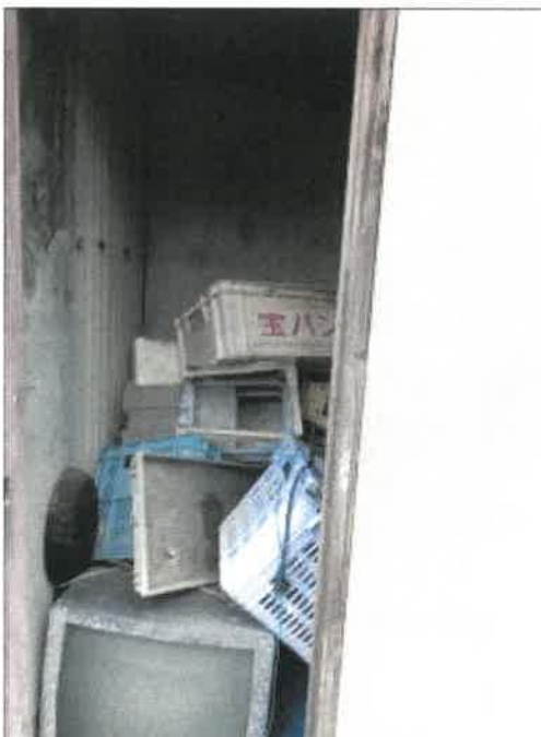
物件 2 の元の建物南東角増築部分内部の状況
