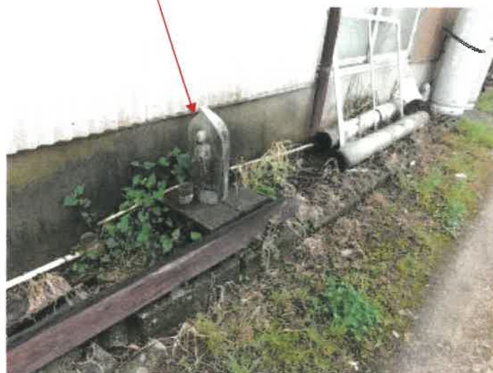
物件2元の建物北側東寄り付近の小さな地蔵の状況
