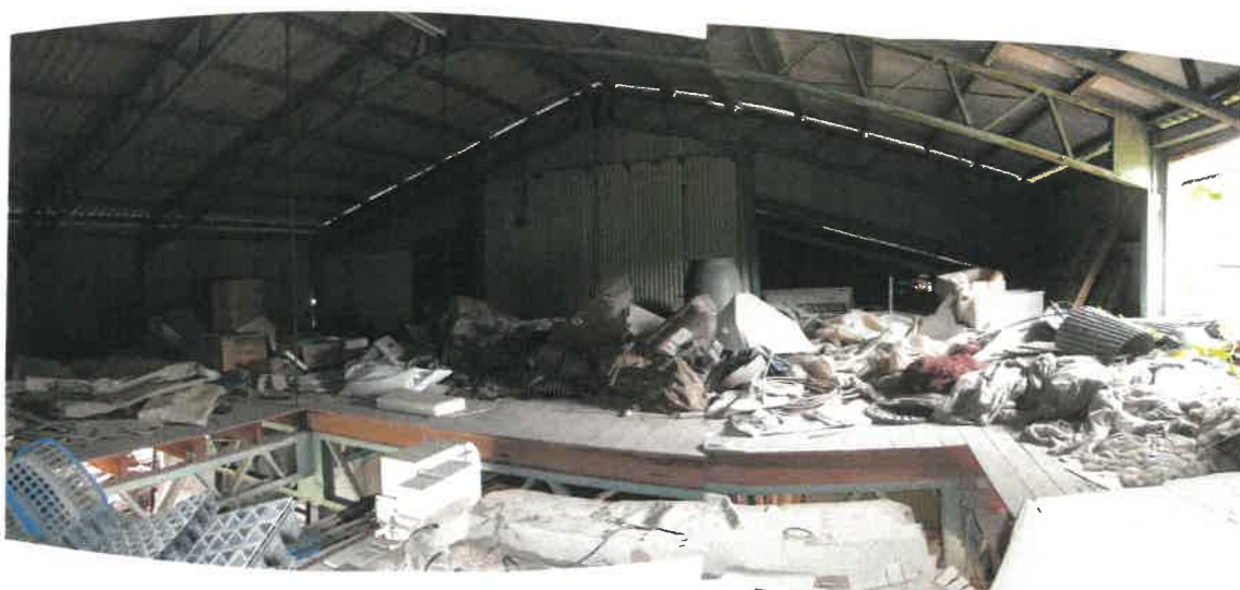
物件 2 建物西側倉庫内 2 階部分の状況
