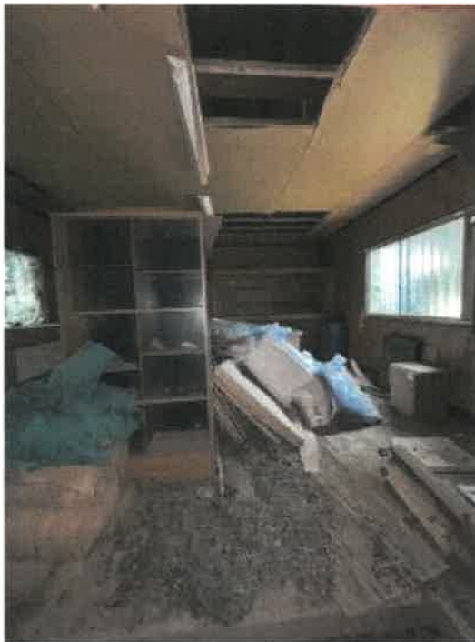
物件2 倉庫内の状況
