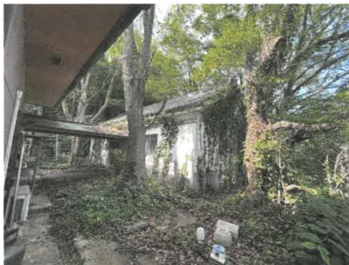
物件2 附属建物符号2（倉庫）の状況
