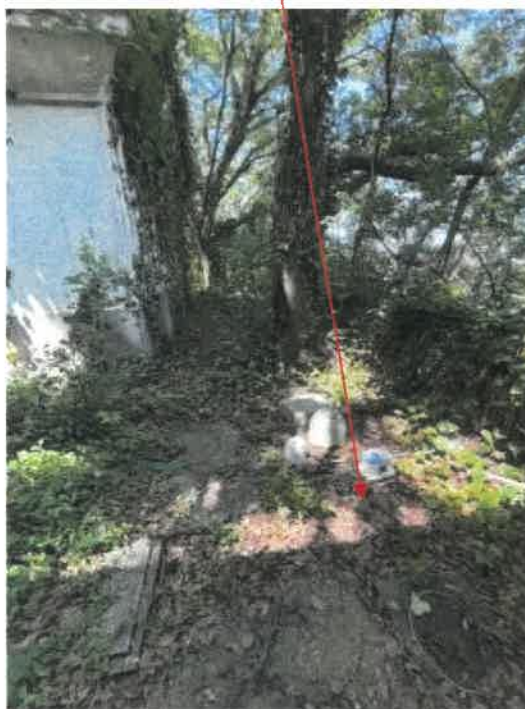
物件2 附属建物2北側の状況
