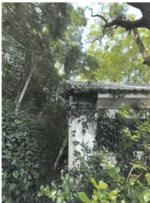
物件2 附属建物2倉庫の南東側の状況
