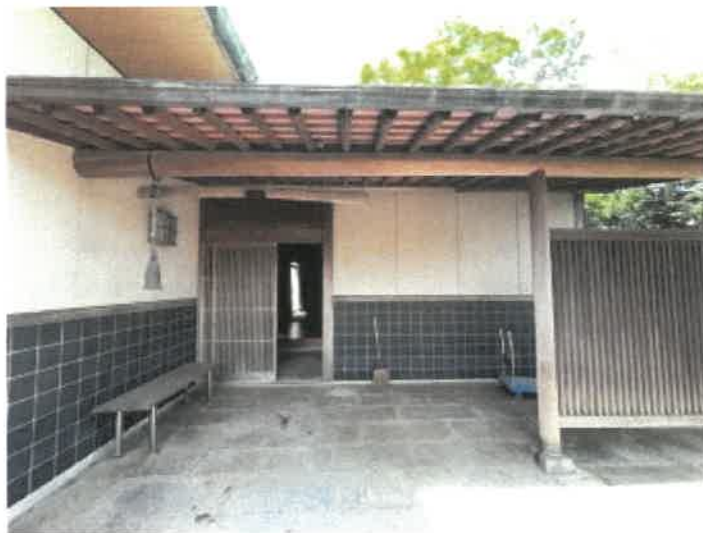
物件2 主である建物玄関付近の状況
