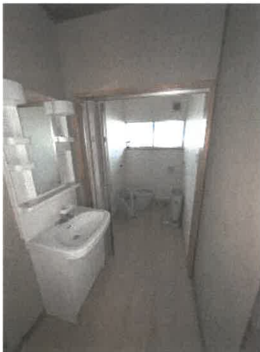
洗面所・トイレの状況
