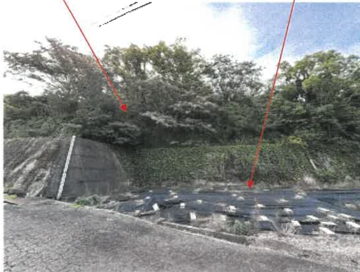
物件 1 北西側の状況
