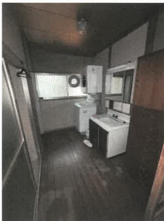
物件 2 洗面脱衣所付近の状況
