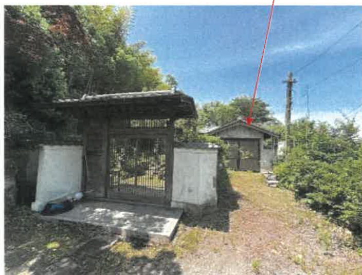
物件1 門扉付近の状況
