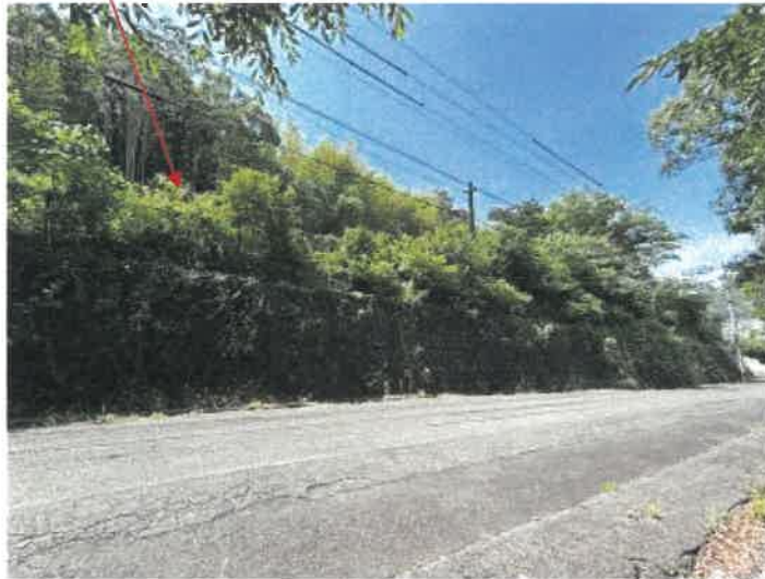
物件 1 北側付近の状況
