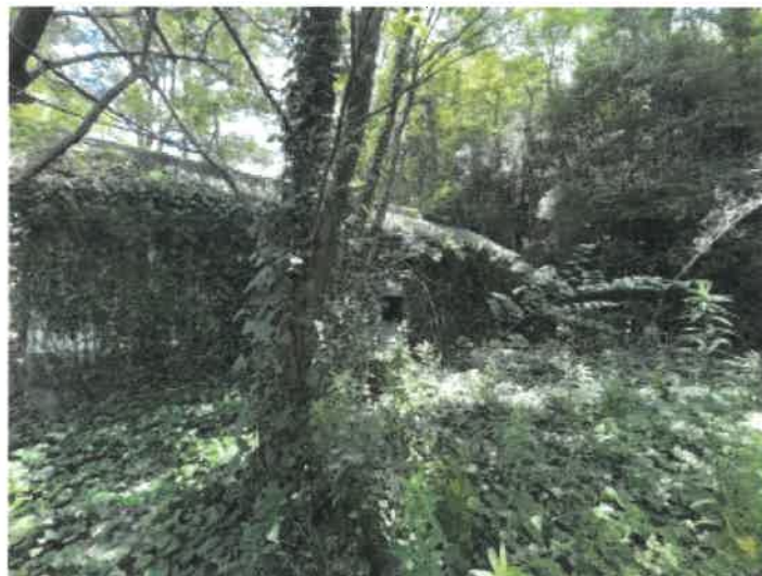
物件2 附属建物2北西側の状況
