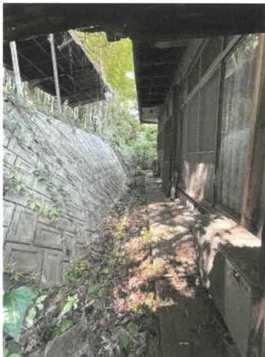
物件1 南側の状況
