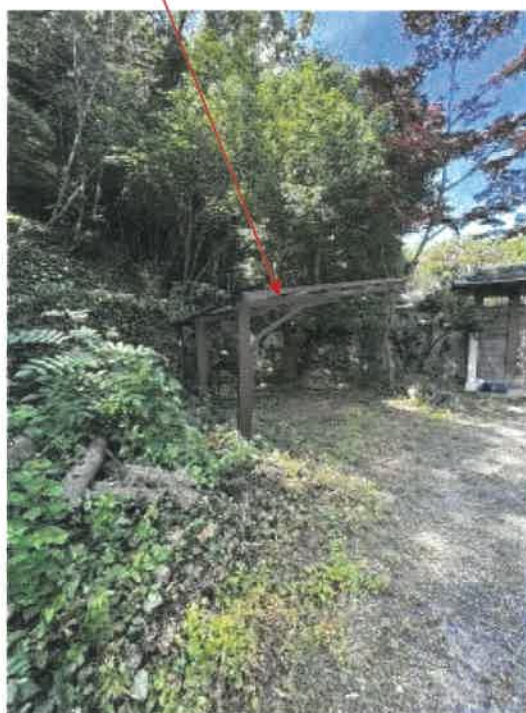
物件1 東側の状況
