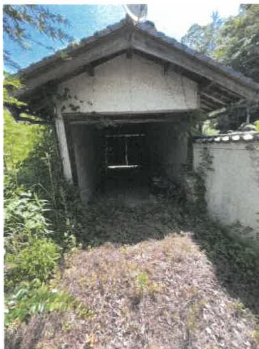
物件2 附属建物符号1（車庫）内の状況
