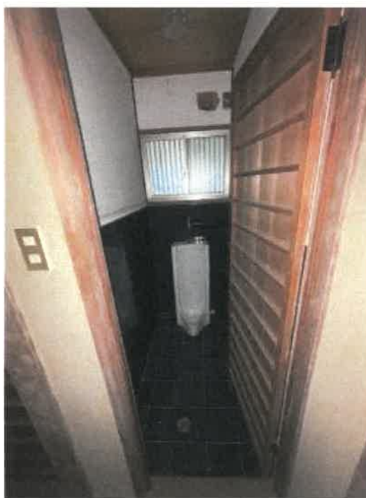
物件2 トイレの状況
