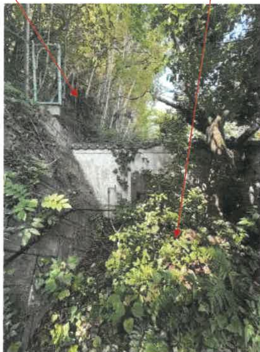
物件 1 南東側法面の状況
