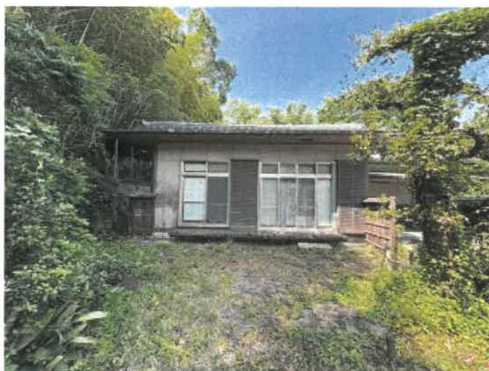
物件 2 主である建物東側の状況
