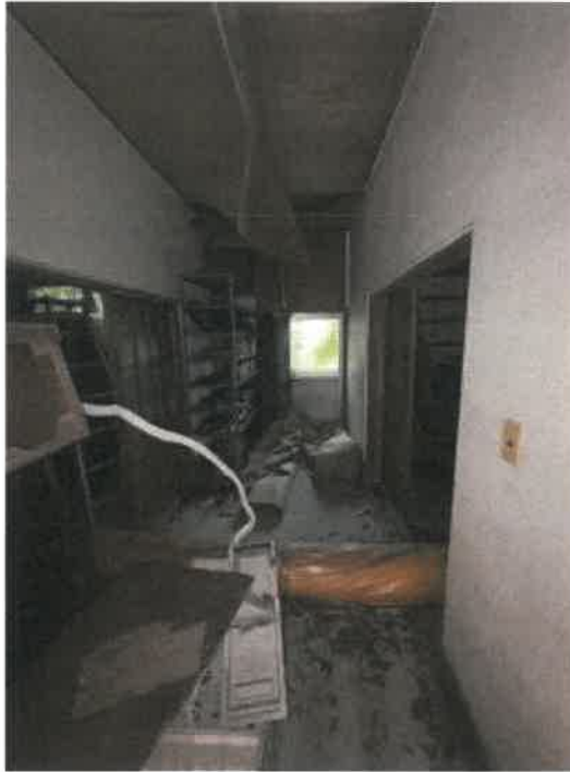
物件2 倉庫内の状況
