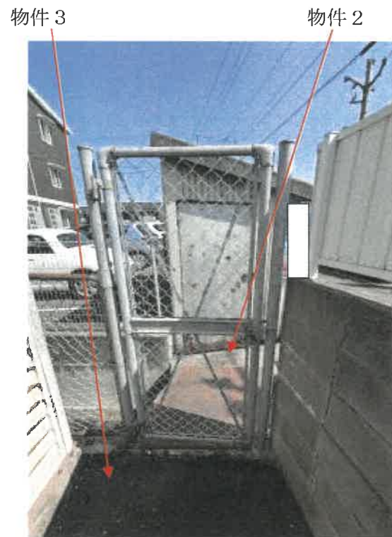
物件 2 と物件 3 の通路の状況
