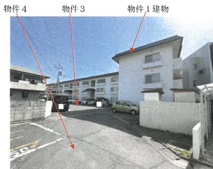
本件物件南西側の状況
