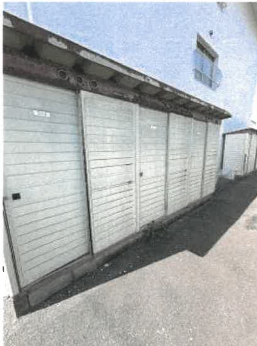
物件3 敷地内物置の状況
