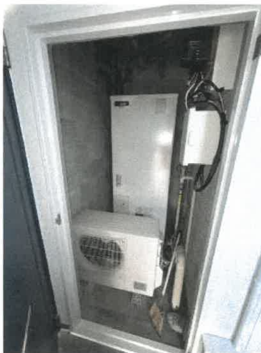
物件1 玄関横の給湯機等の状況
