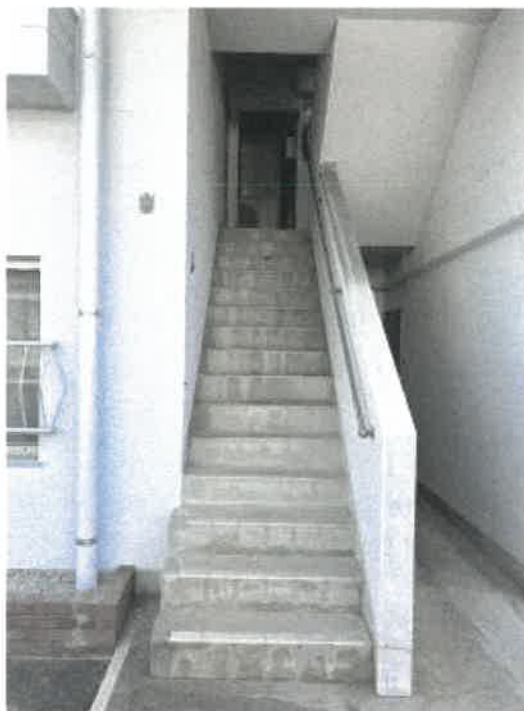
物件1 階段の状況
