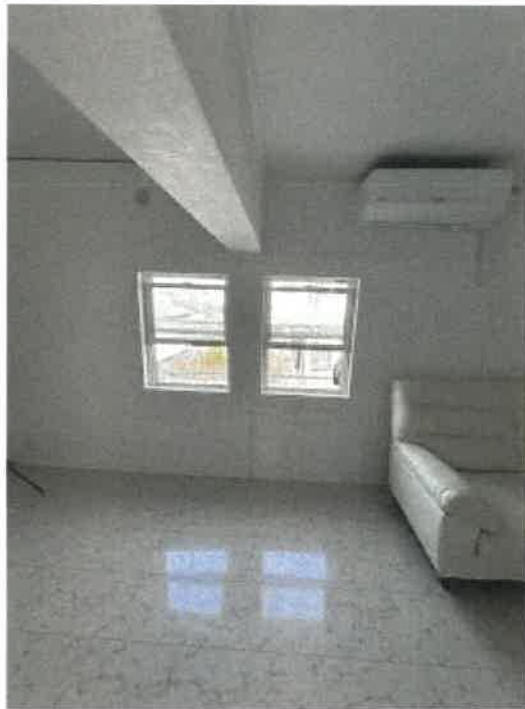
物件1 北西側洋室の窓の状況
