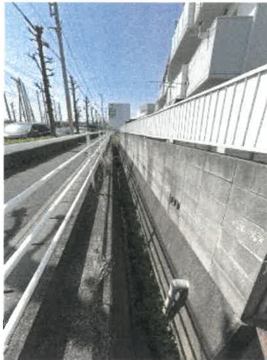
物件5（用悪水路）の状況
