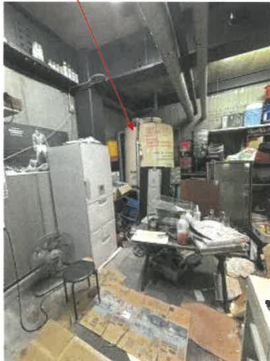
物件2 店舗北東側のバックヤードの状況
