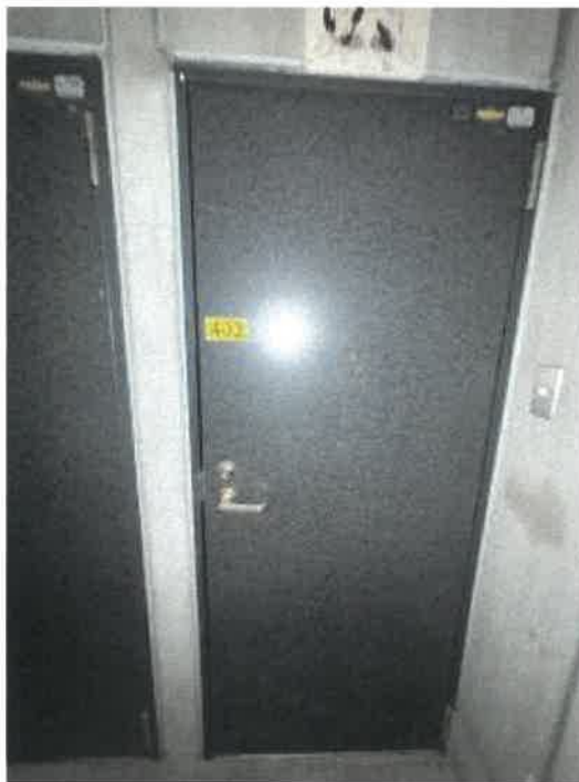
物件4 4階402号室玄関入口ドアの状況
