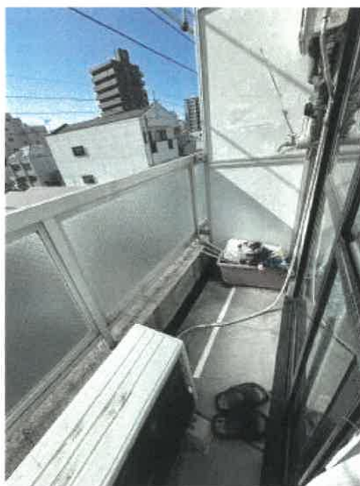
物件4 4階403号室ベランダの状況
