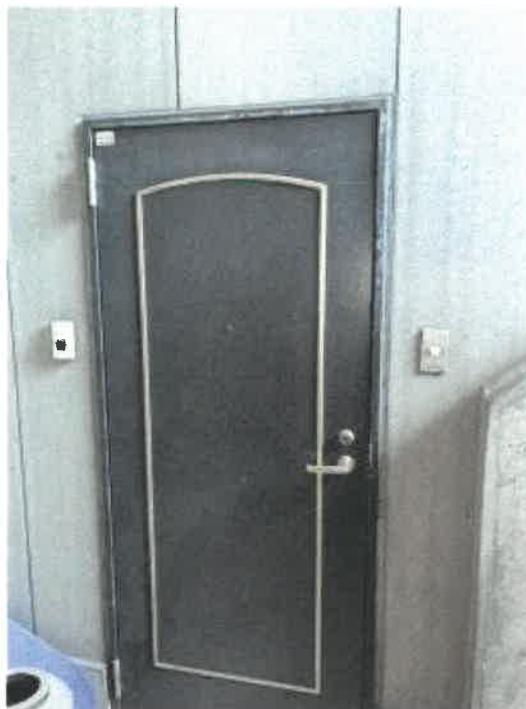
物件3 2階玄関入口ドアの状況
