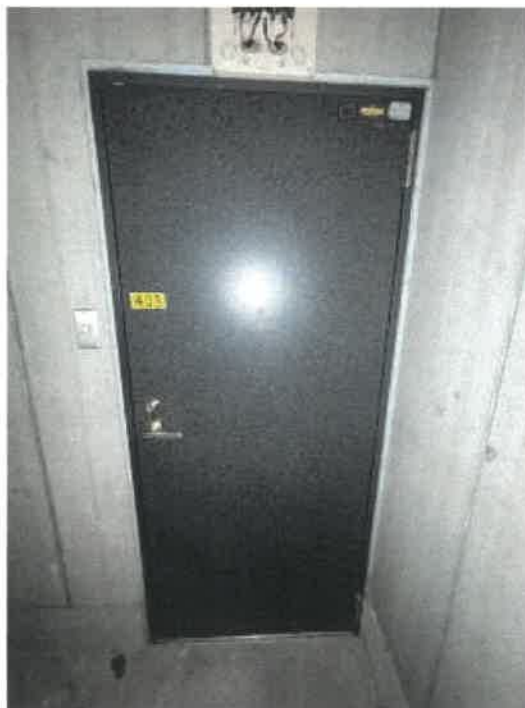
物件4 4階403号室玄関入口ドアの状況
