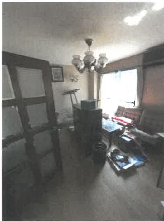
物件3 2階西側洋室の状況
