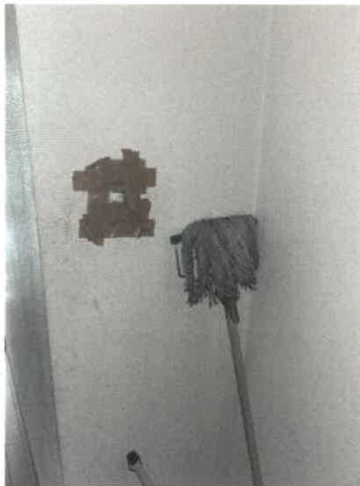
物件4 4階403号室玄関付近のスイッチ部分の状況
