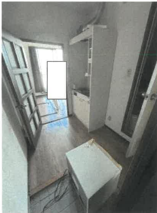
物件4 4階402号室玄関付近の状況
