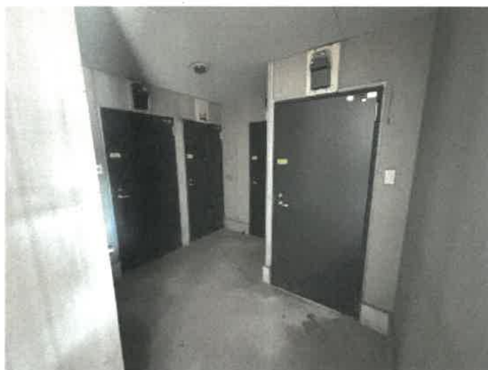
物件4 4階共用廊下の状況
