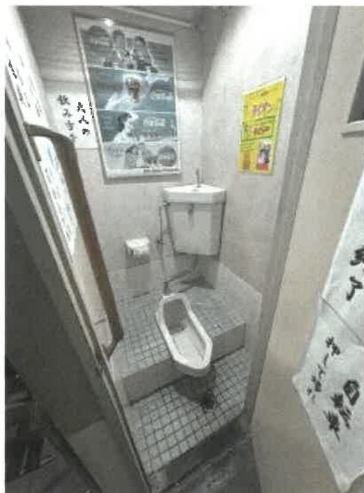
物件2 店舗北側のバックヤード内トイレの状況
