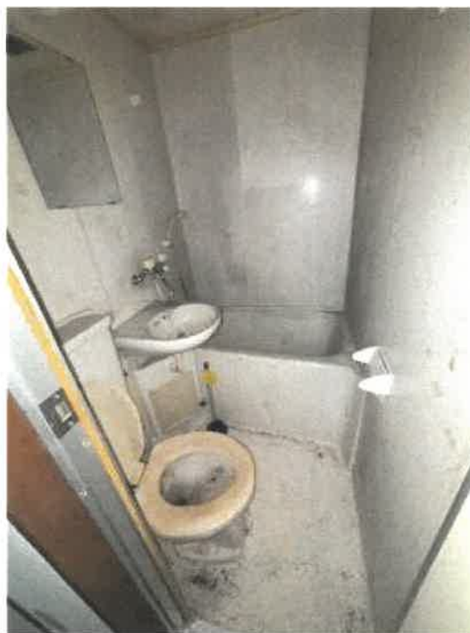
物件4 4階402号室ユニットバスの状況
