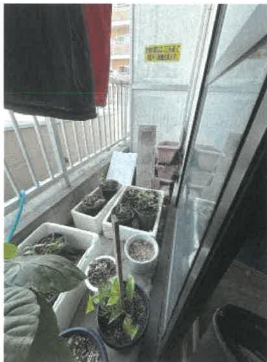
物件3 3階北東側洋室外ベランダの状況
