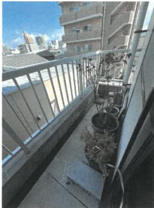
物件3 3階南東側洋室外ベランダの状況
