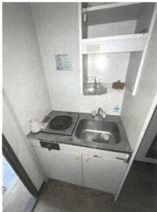
物件4 4階402号室台所の状況
