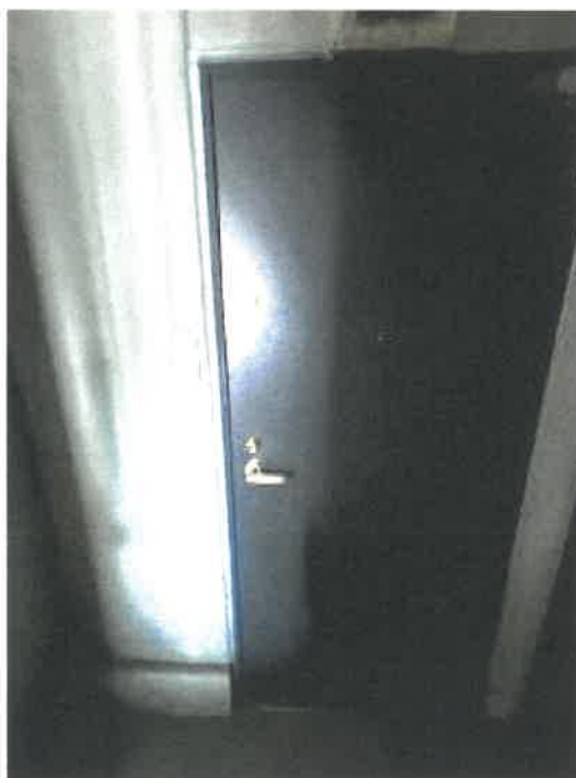
物件3 3階301号室玄関入口ドアの状況
