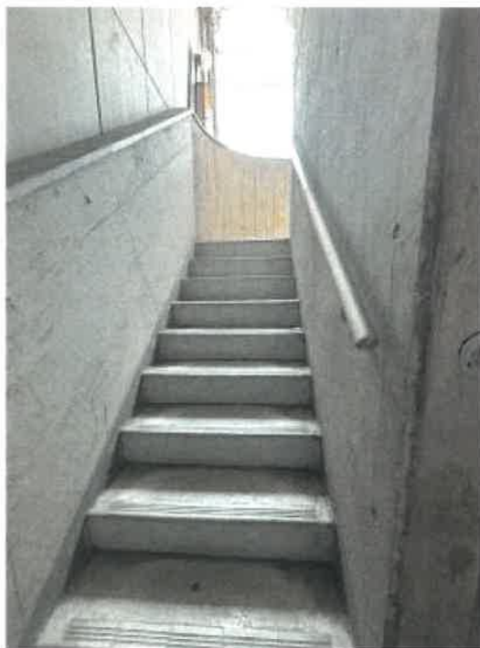
物件 1 北側外階段の状況
