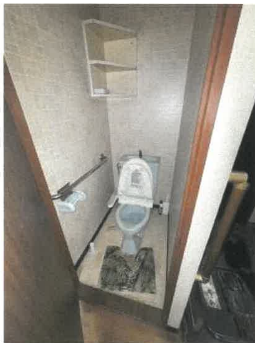
物件3 2階トイレの状況
