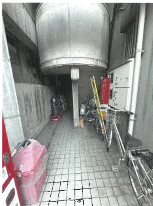
物件1 北西側の状況
