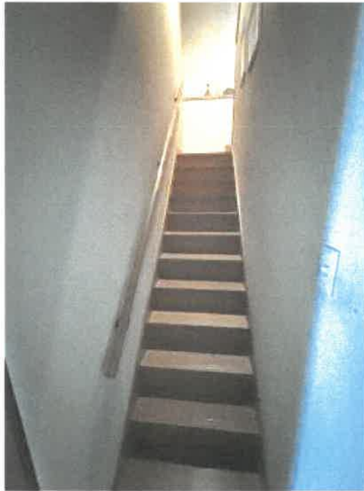
物件3 2階階段の状況
