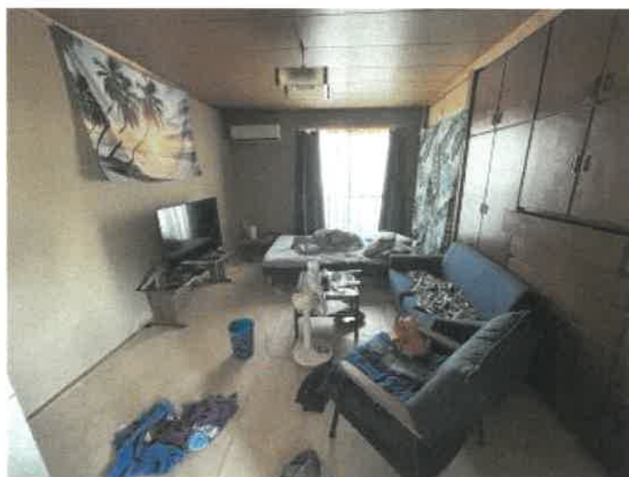
物件3 3階南東側洋室の状況
