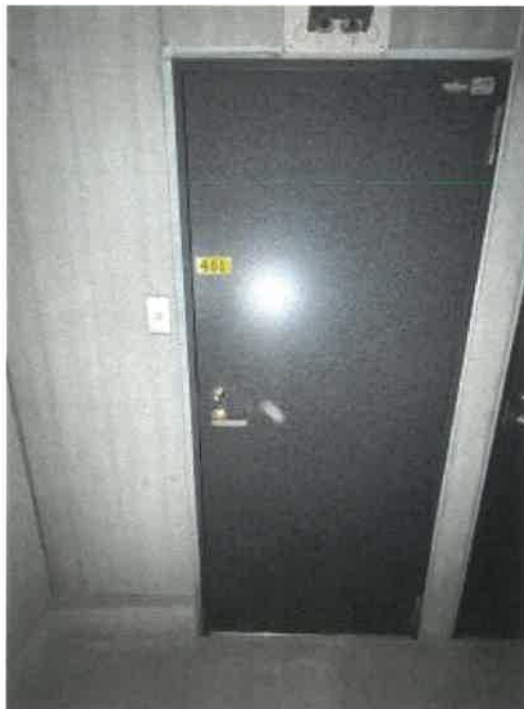
物件4 4階401号室玄関入口ドアの状況
