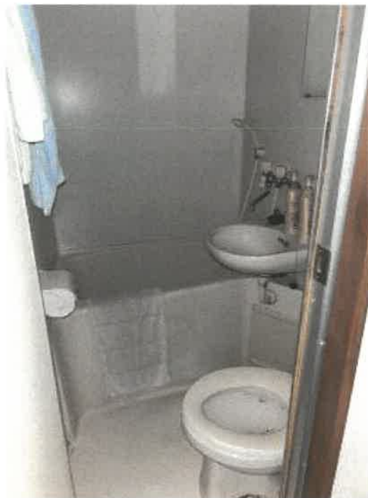
物件4 4階403号室ユニットバスの状況
