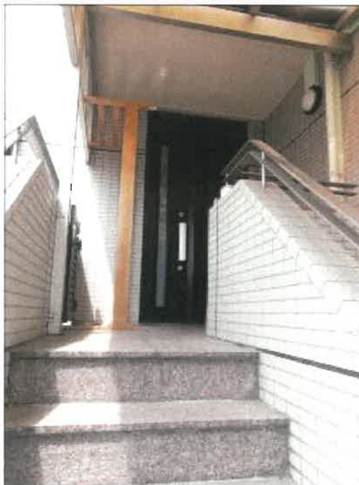
物件5建物への階段の状況
