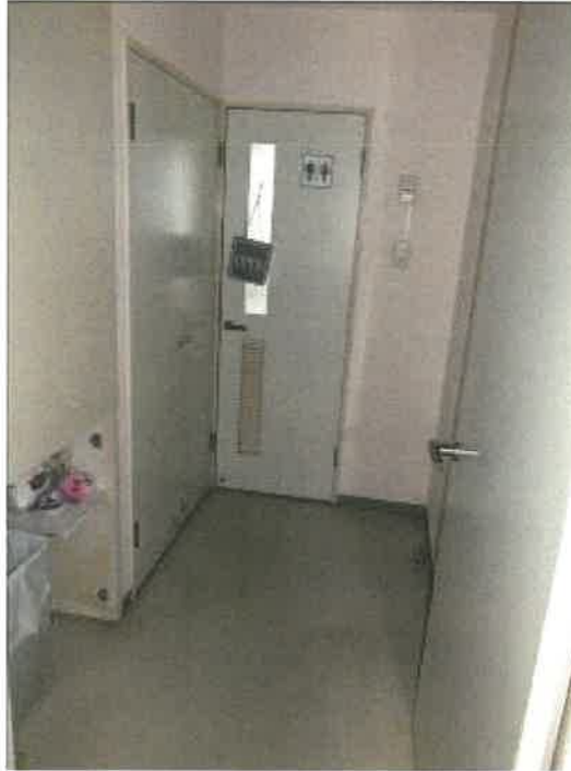
物件 4 建物の東列湯沸室北側の状況
