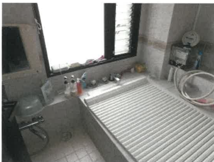
物件5建物の浴室の状況
