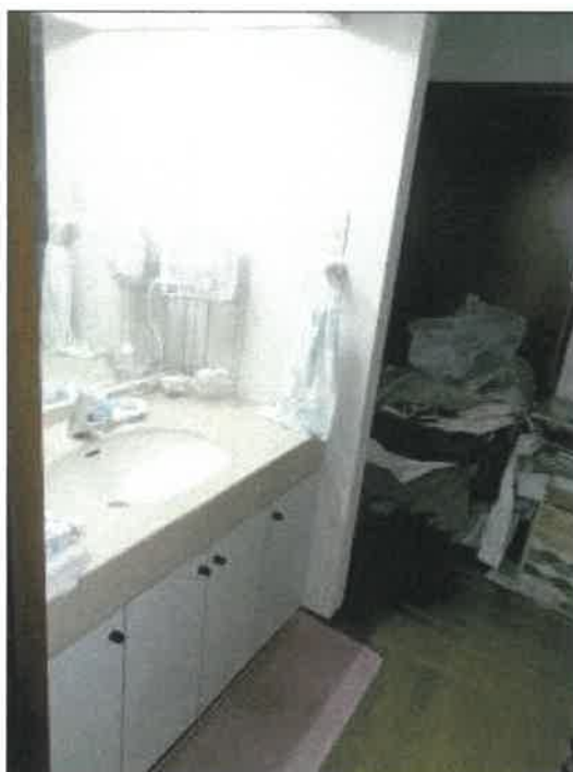
物件5 建物のトイレの前の洗面所の状況
