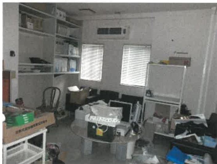
物件 4 建物の東列湯沸室北側倉庫の状況
