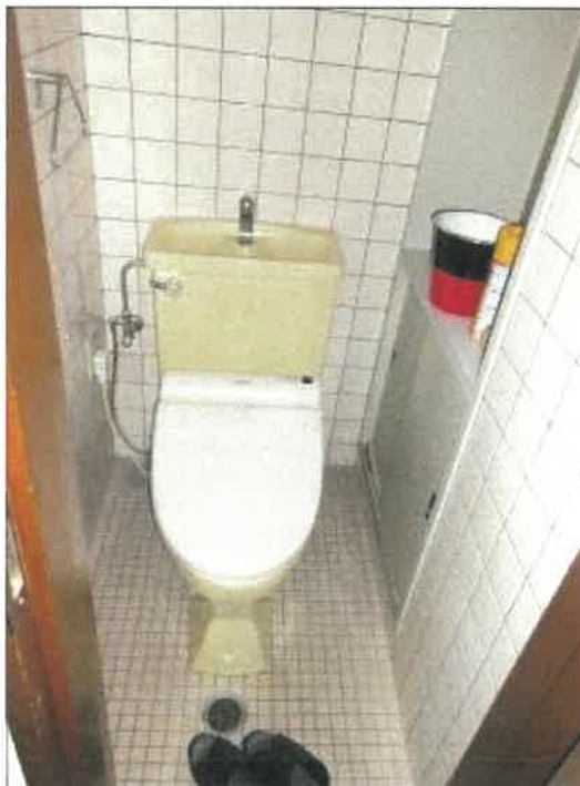
物件5建物のトイレの状況
