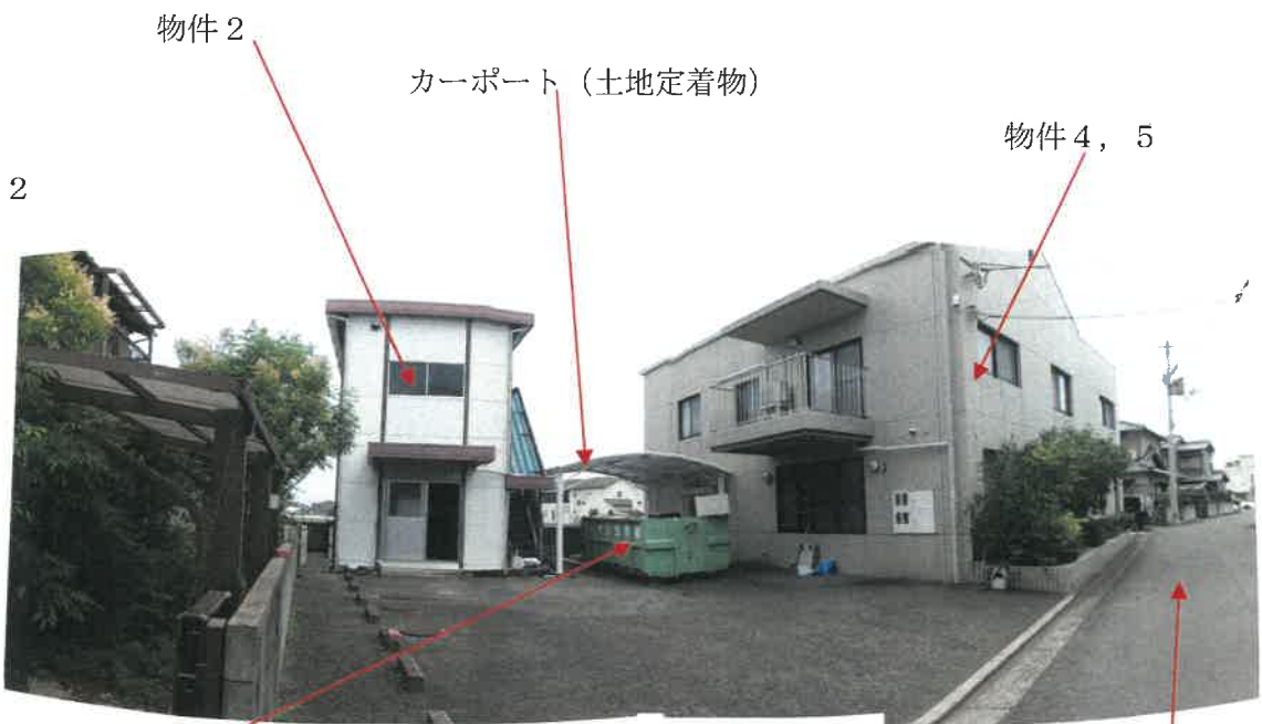
物件1, 3土地北西側及び北東側境界付近の状況 廃棄物（ゴミ）回収のコンテナ 舗装私道（香川県三郎池土地改良区所有、建築基準法上の道路ではない）
