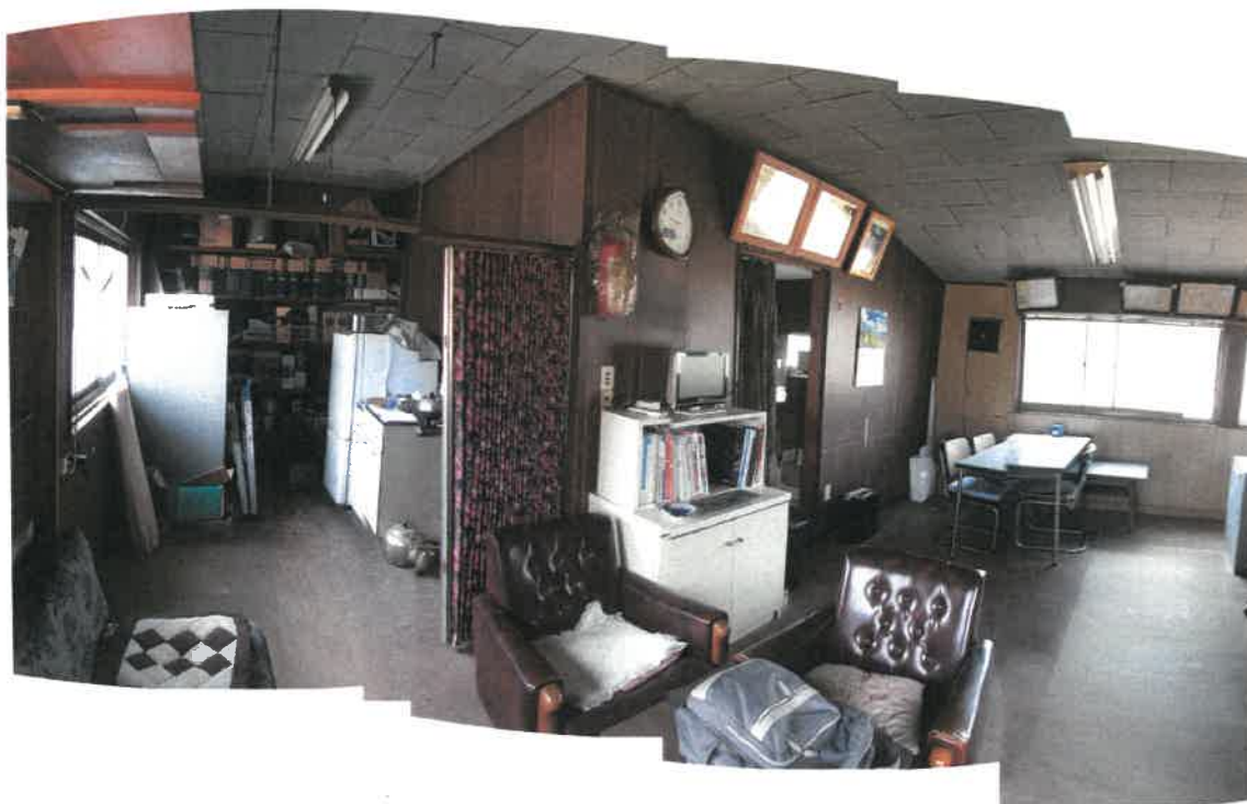
物件 3 附属建物符号 1 の事務所及び給湯室の状況
