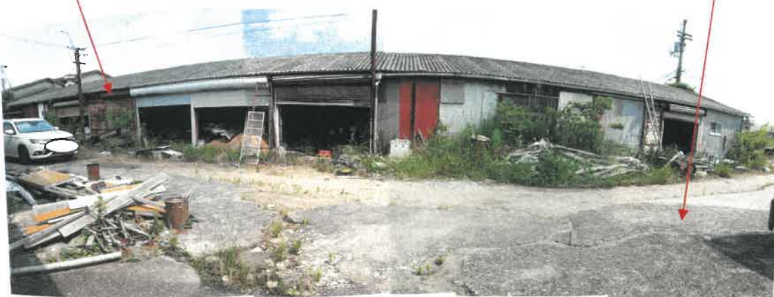
物件3主である建物南側の状況
