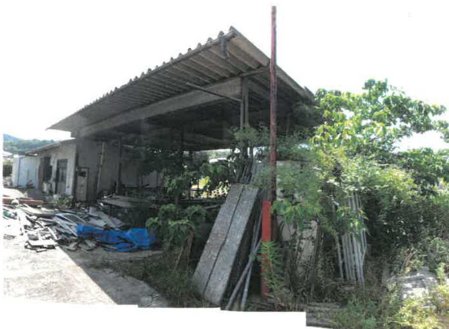
物件 3 附属建物符号 1 の南西側構築物（土地定着性あり）の状況
