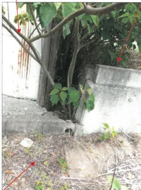
物件 1 土地南側境界付近の状況
