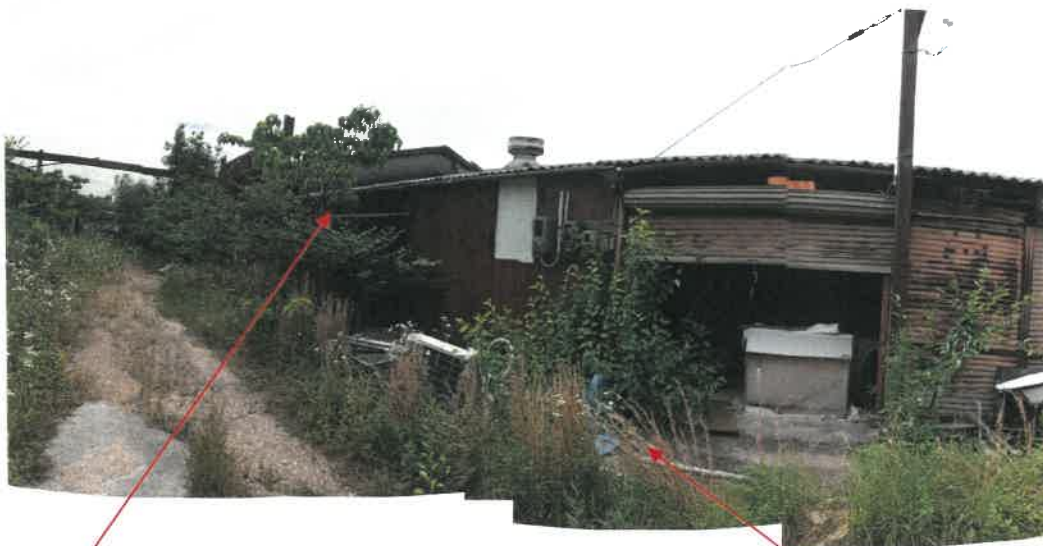
物件3主である建物南側の状況
