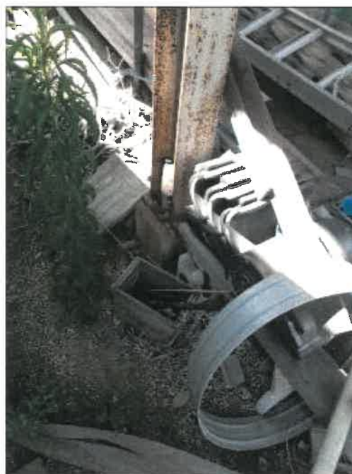
物件 3 附属建物符号 1 の南西側構築物（土地定着性あり）のコンクリート基礎の状況
