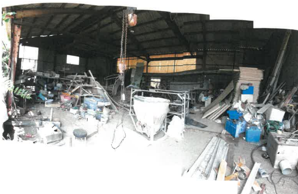
物件 3 主である建物の南西側端の区画部分の内部の状況
