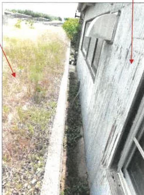
物件 1 土地南側境界付近の状況
