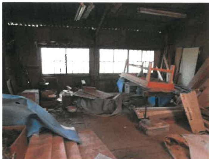
物件 3 主である建物南西側端から 2 区画目の作業所内部の状況
