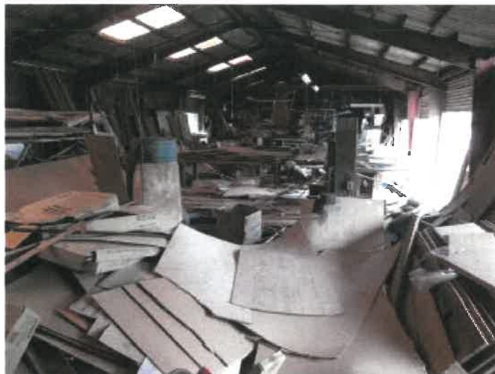
物件 3 主である建物北東側作業所内部の状況
