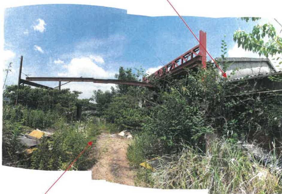
物件 3 主である建物の南西端付近の状況
