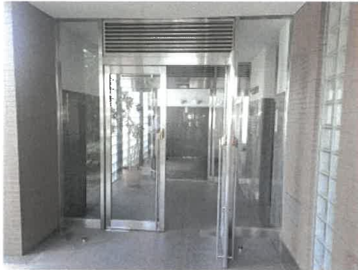
エントランスの状況
