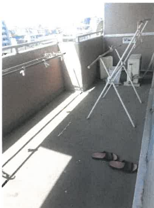
受命物件（603号室）のベランダの状況
