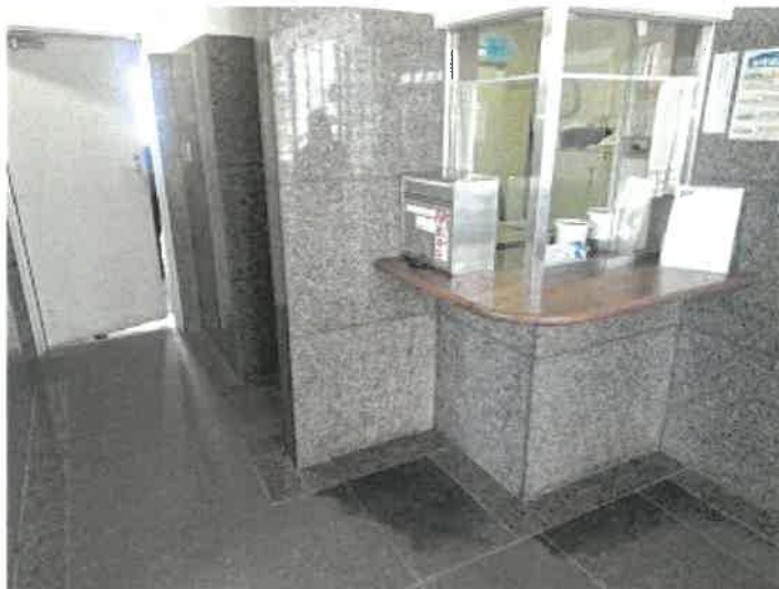
管理人室周りの状況
