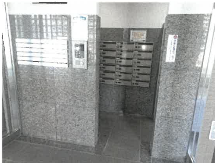
玄関ホールのインターホン付近の状況
