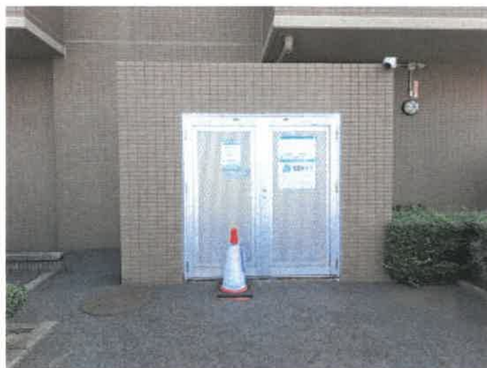
ゴミ置場の状況
