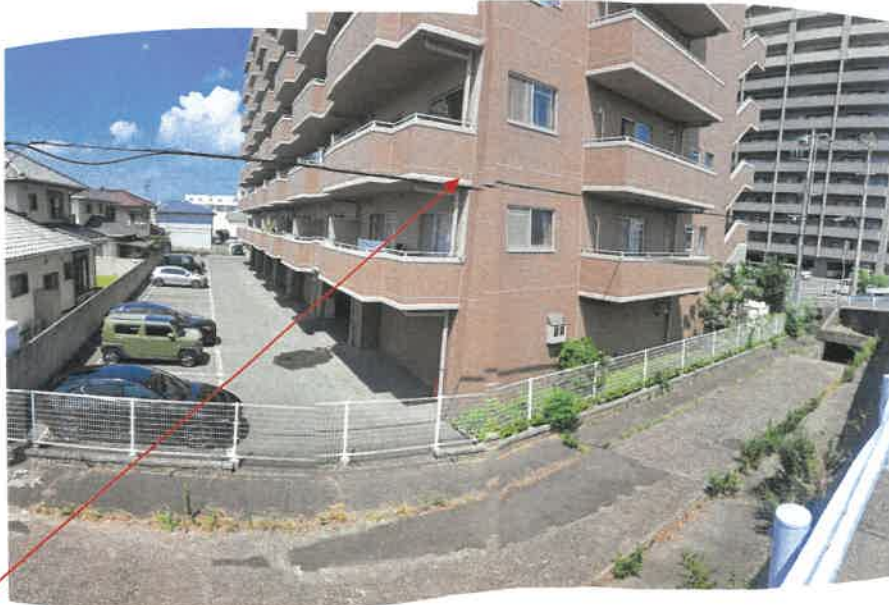
受命物件（603号室）の存在するマンション南側（駐車場）の状況 受命物件（603号室）の存在するマンション
