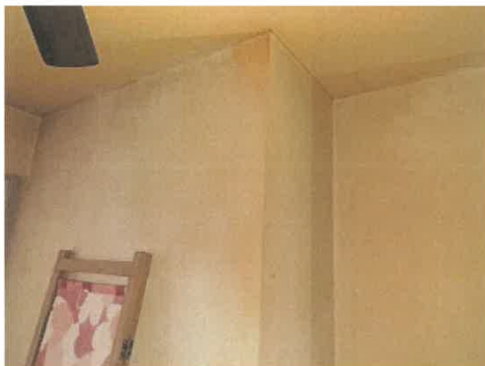
受命物件（6 0 3 号室）の北側西洋室の壁紙のヤニ被害の状況
