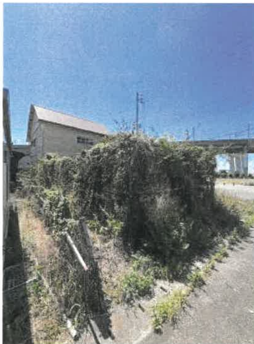
本件物件南東側の状況
