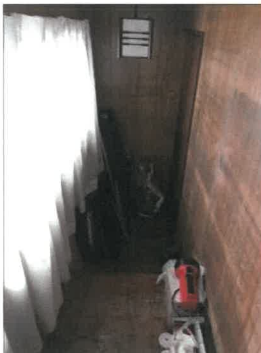
物件 2 建物の 2 階東側の北廊下の状況
