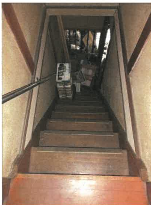
物件2建物の階段の状況
