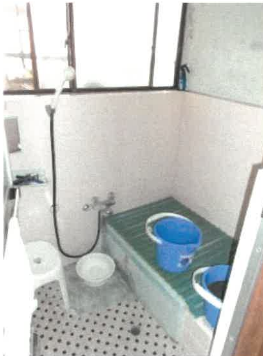
物件 2 建物の 1 階浴室の状況
