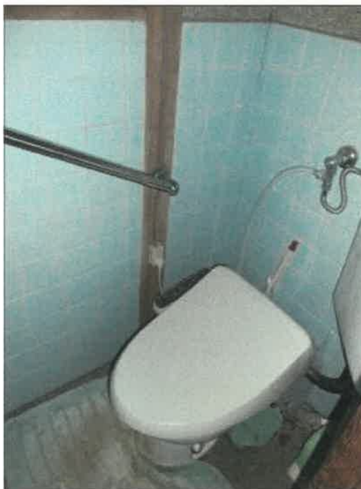
物件2建物の1階トイレの状況
