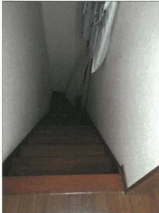
物件2 建物の階段の状況
