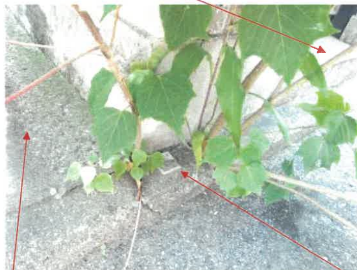
物件1土地北西角点付近の状況
