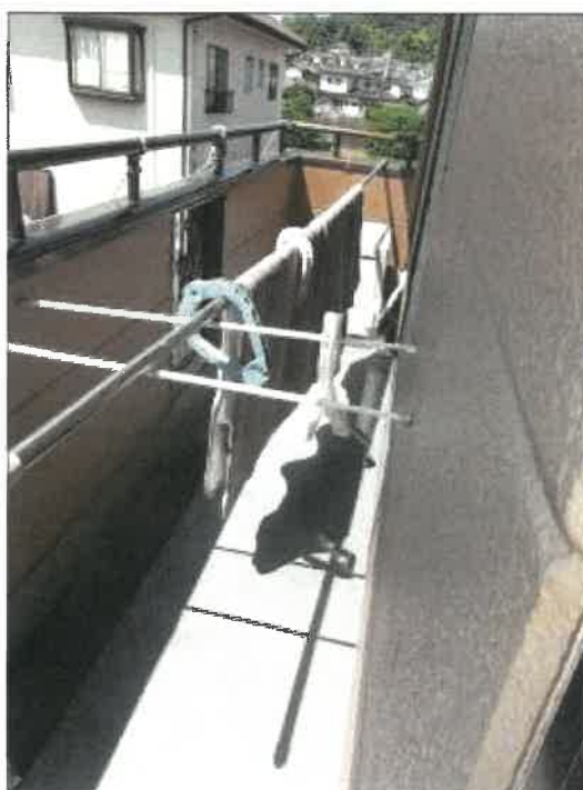
物件 2 建物の 2 階ベランダの状況
