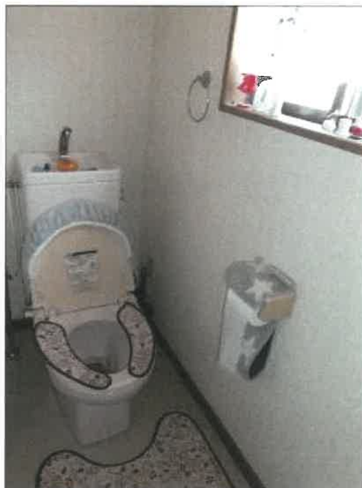
物件 2 建物の 2 階トイレの状況
