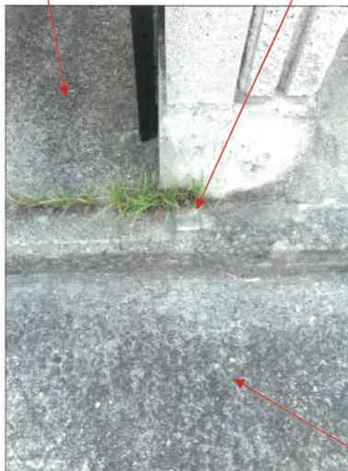
物件 1 土地南西角点付近の状況
