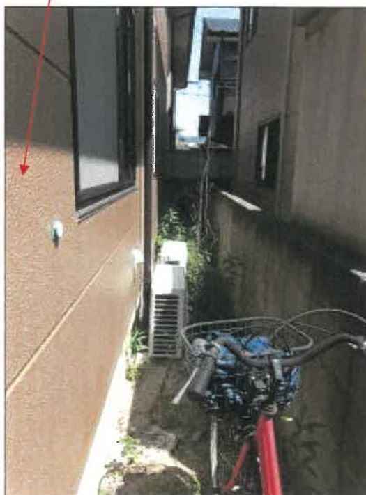
物件 2 建物ほぼ東側の状況
