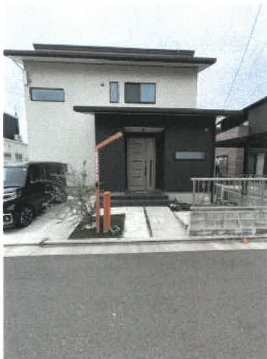
物件2 玄関付近の状況
