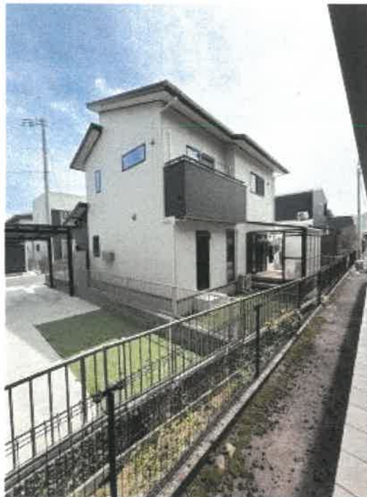
物件1 東側の状況
