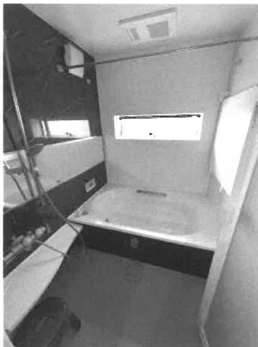
物件2 1階浴室の状況
