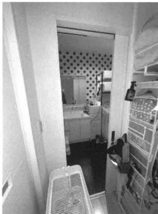
物件2 1階洗面脱衣室の状況
