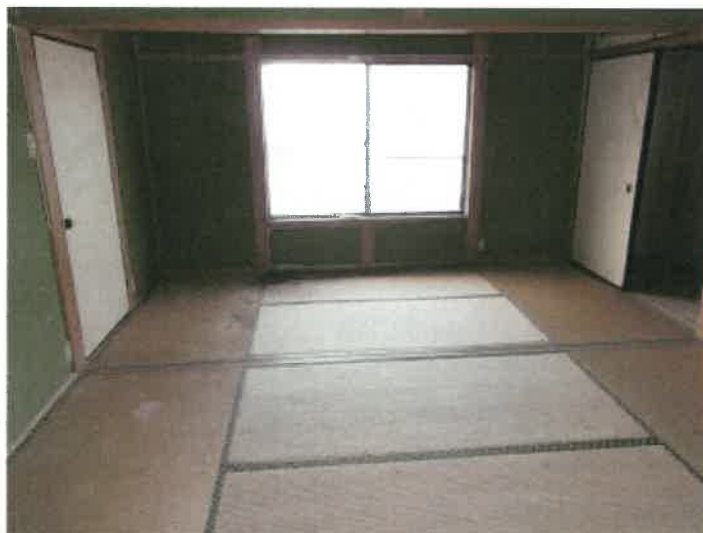
物件 5 建物の 2 階和室の状況
