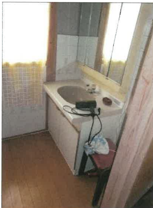
物件5建物の1階手洗いの状況
