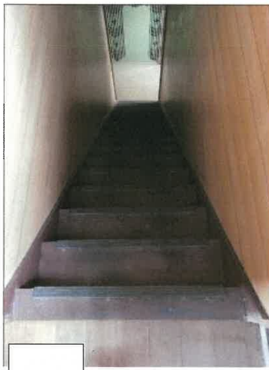
物件 5 建物の階段の状況
