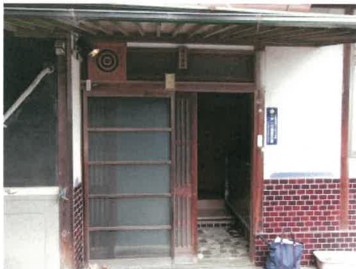
物件4主である建物の1階玄関付近の状況
