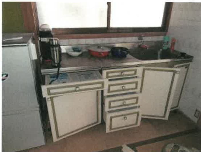
物件 5 建物の 1 階食堂のキッチン周りの状況
