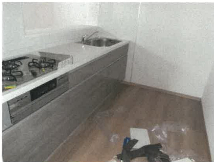
物件 2 建物の 1 階キッチンの状況
