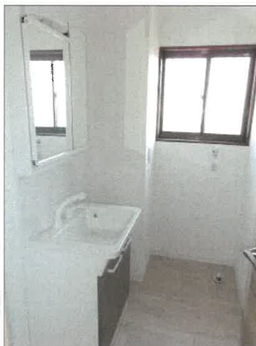
物件 2 建物の 1 階洗面脱衣所の状況
