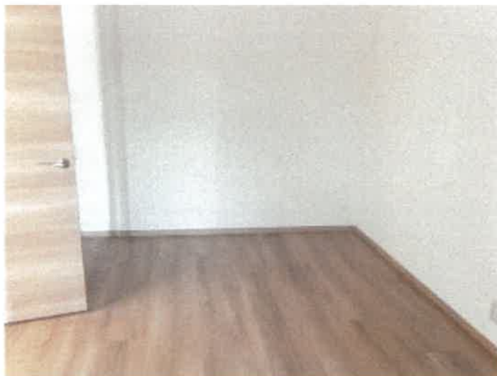
物件 2 建物の 1 階北側洋室の状況
