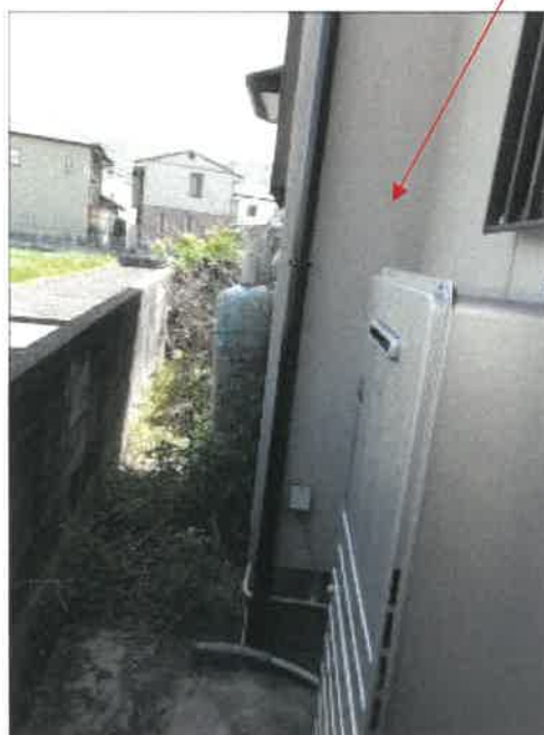
物件 2 建物の北側の状況
