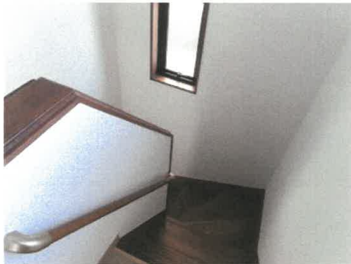
物件2 建物の階段の状況
