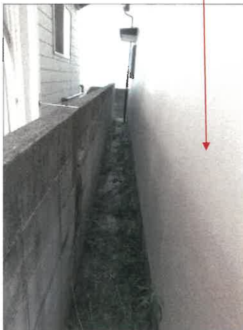
物件 2 建物の北西側の状況
