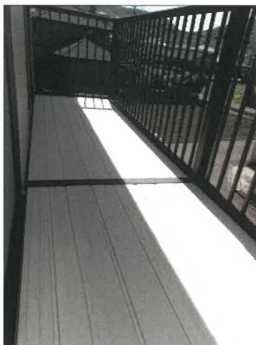
物件2建物の2階南西側のベランダの状況
