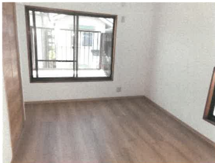
物件 2 建物の 2 階北西側洋室の状況
