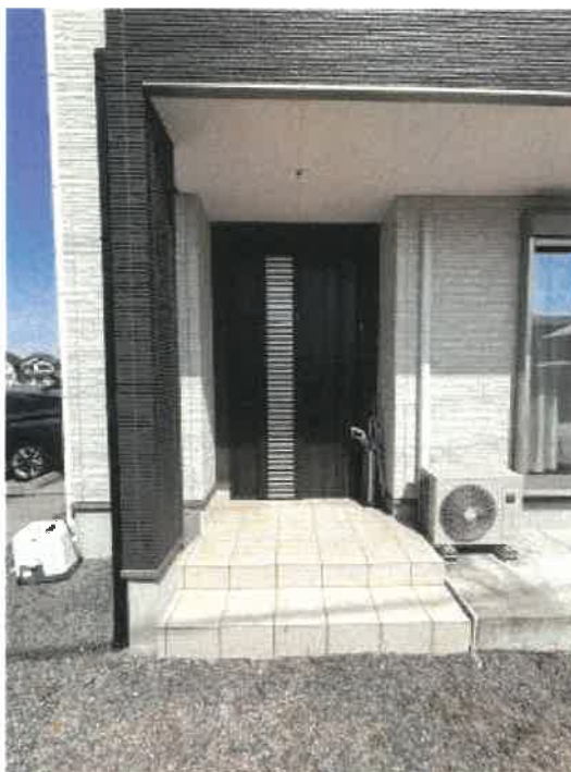
物件2 玄関付近の状況
