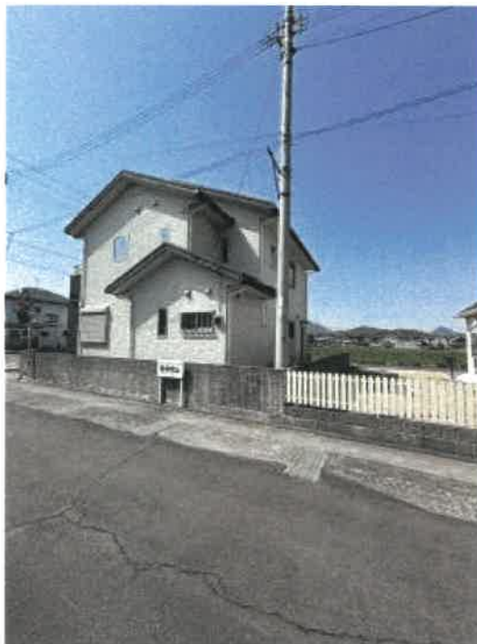
本件物件の北東側の状況
