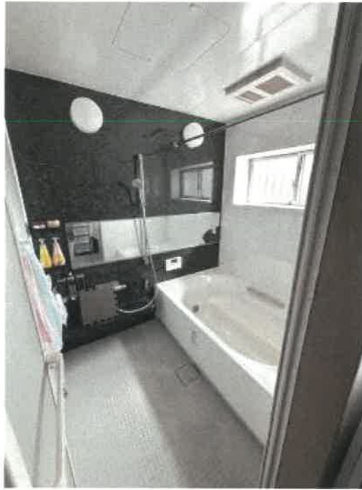
物件 2 1 階浴室の状況
