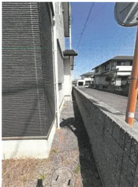
物件1 東側の状況
