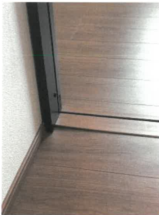
物件 2 2階北西側洋室入口敷居の状況
