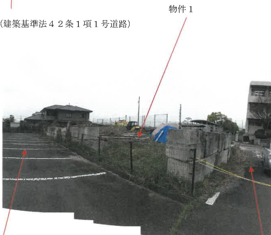
物件1 土地東側及び南側境界付近の状況
