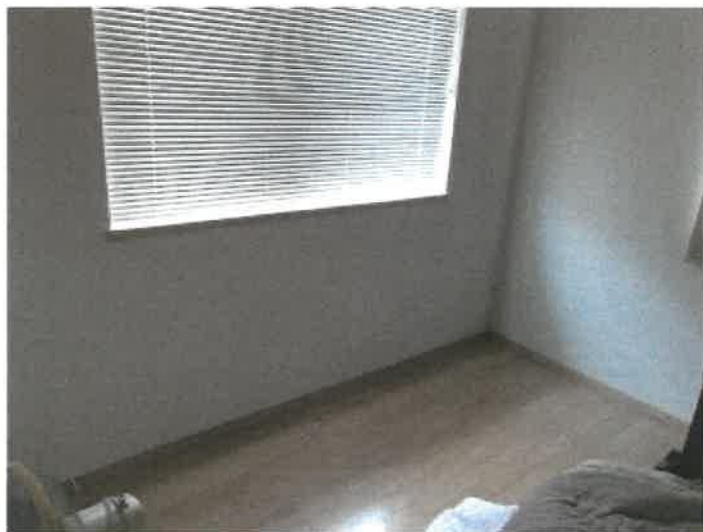
物件 3 建物の 2 階北東側端の洋室の収納室の状況
