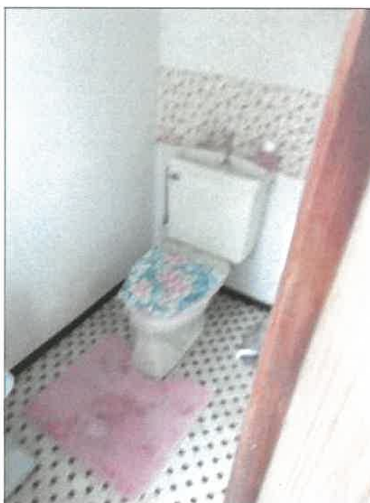
物件 2 建物の 1 階西角のトイレの状況
