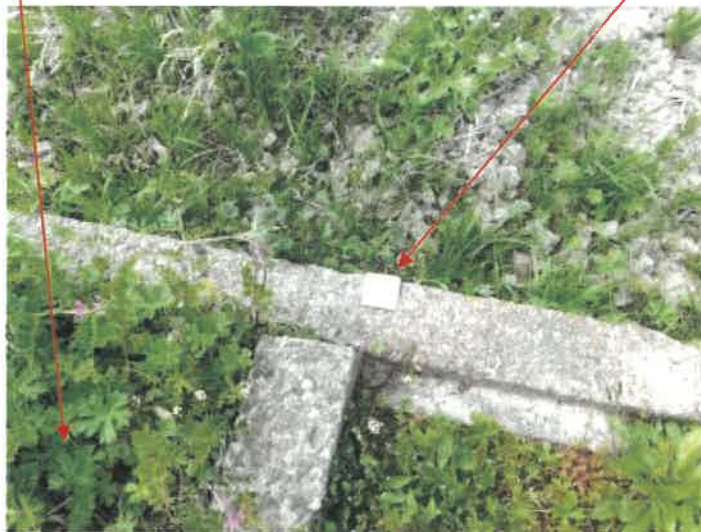
目的外土地甲1883番5北角点付近の状況
