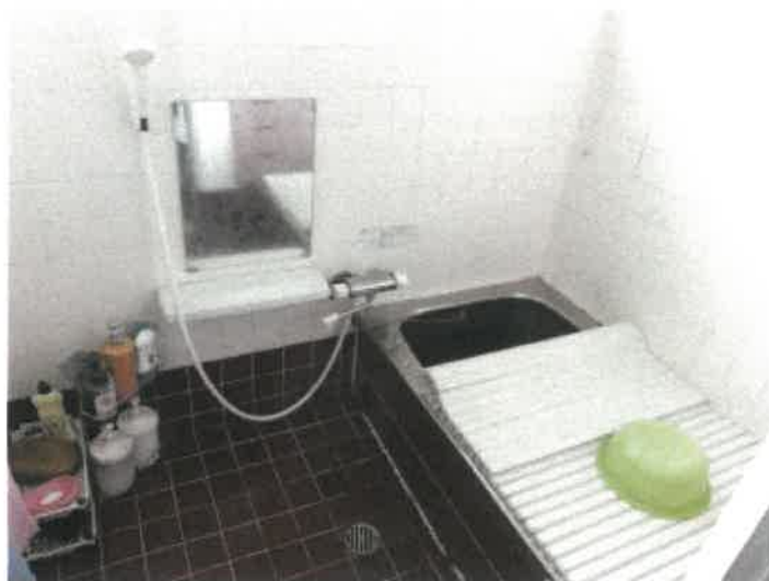
物件 2 建物の 1 階浴室の状況
