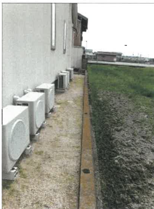
物件3建物北西側の状況
