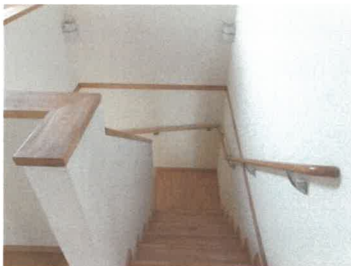
物件 3 建物の階段の状況
