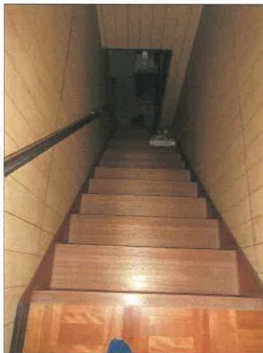
物件2 建物の階段の状況
