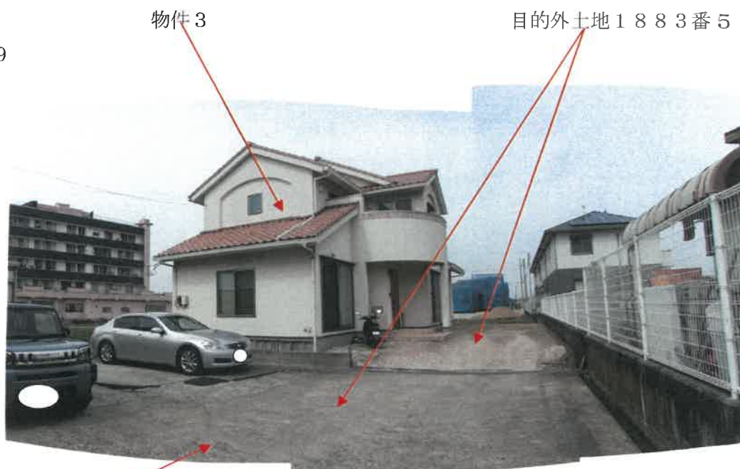
物件3建物の南西側及び南東側の状況
