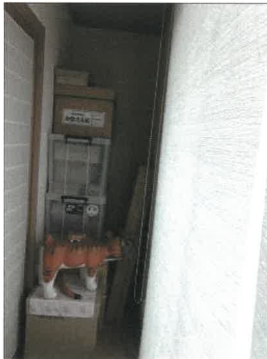
物件 3 建物の 1 階南西側和室南東側広縁の状況
