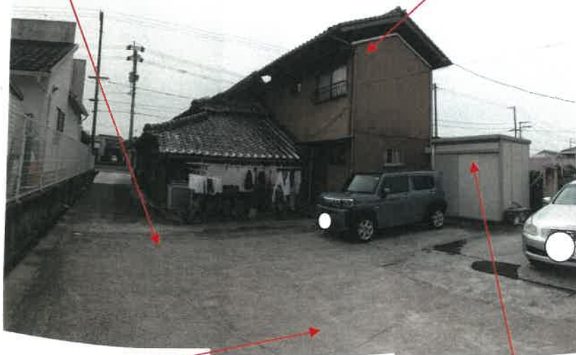
物件2 建物の北東側及び南東側の状況
