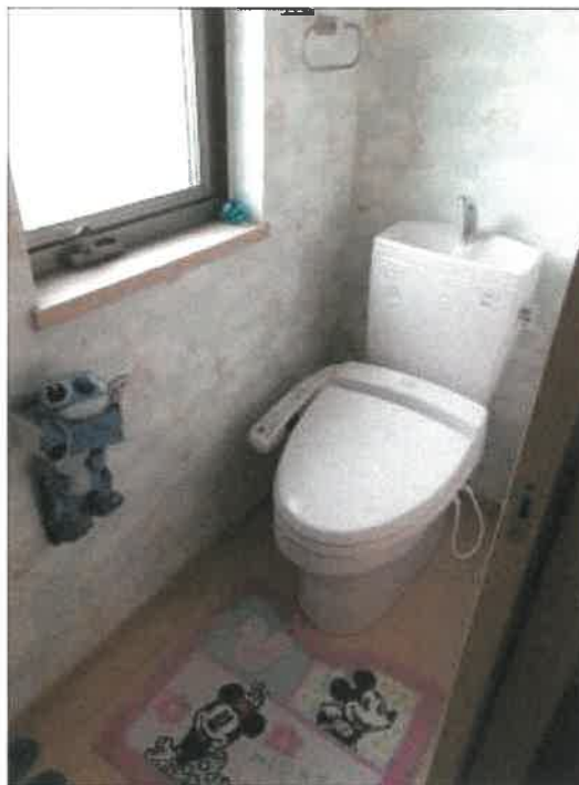
物件 3 建物の 2 階のトイレの状況
