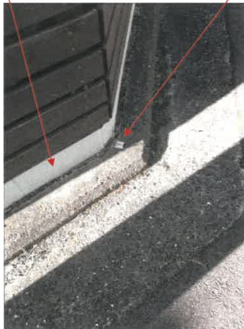
物件2土地北東角付近の状況
