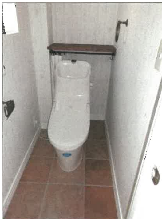
物件 3 建物の 2 階トイレの状況
