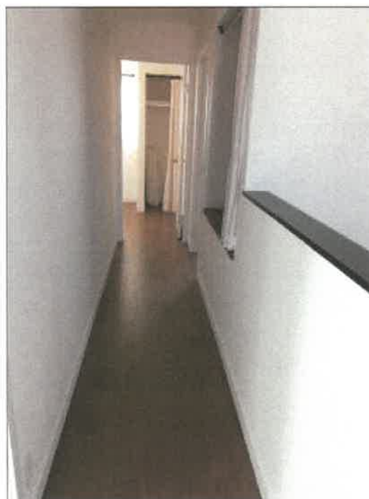
物件 3 建物の 2 階廊下の状況
