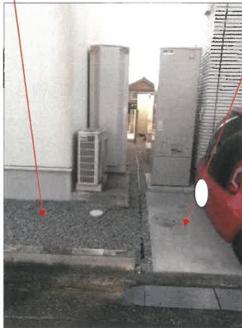
物件2土地西側境界付近の状況
