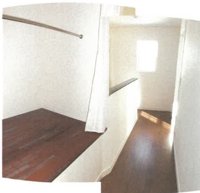
物件 3 建物の 2 階廊下の状況
