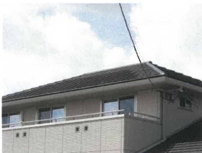
物件 4 建物の太陽光発電パネル内蔵屋根の状況
