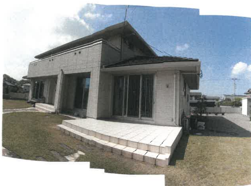
物件 4 建物の東側，南側の状況
