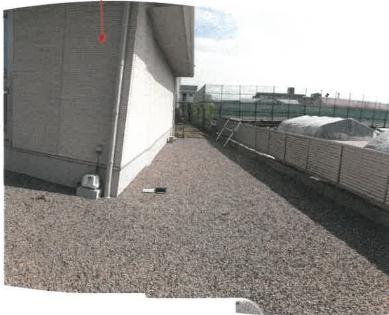
物件 4 建物西側及び北側の状況
