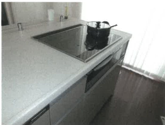
物件4建物の1階キッチンのIHクッキングヒーター設置の状況
