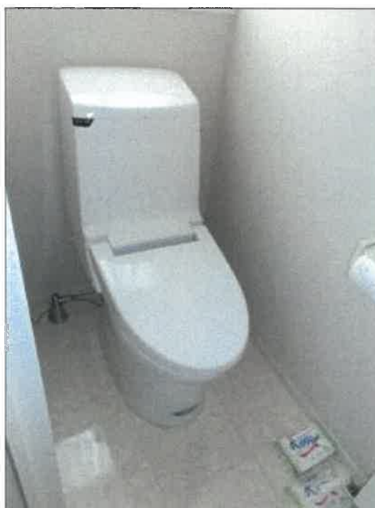
物件 4 建物の 2 階のトイレの状況
