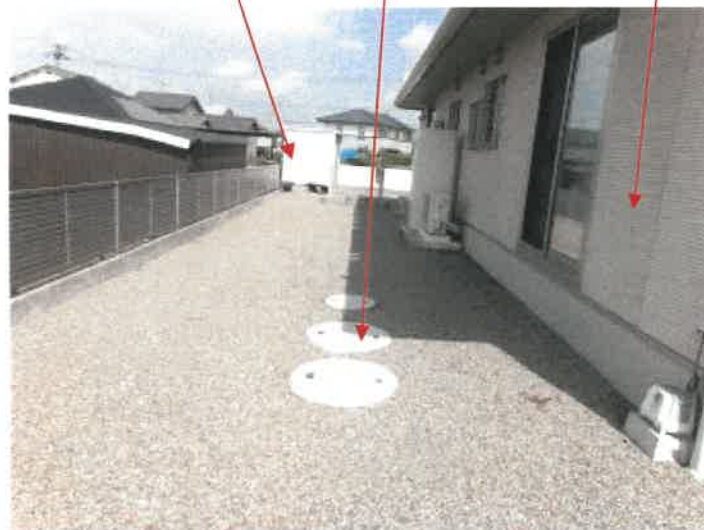
物件 4 建物北側の状況
