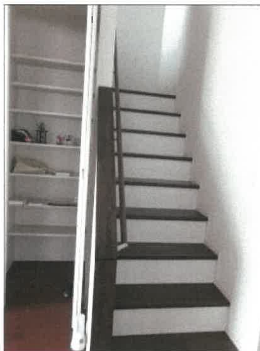
物件 4 建物の階段の状況
