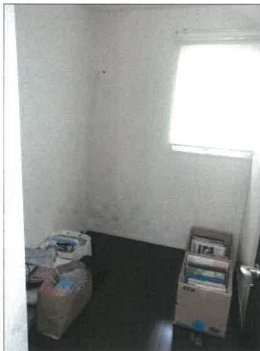
物件 4 建物の 2 階西側洋室の書斎の状況
