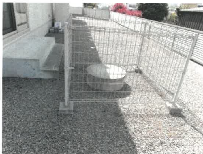
物件 4 建物北東角付近の井戸の状況
