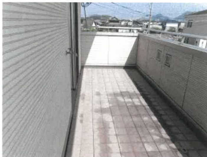
物件 4 建物の 2 階バルコニーの状況
