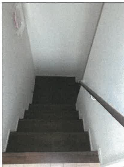
物件 4 建物の階段の状況
