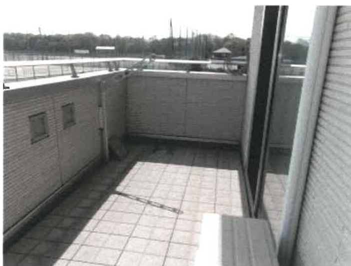
物件 4 建物の 2 階バルコニーの状況
