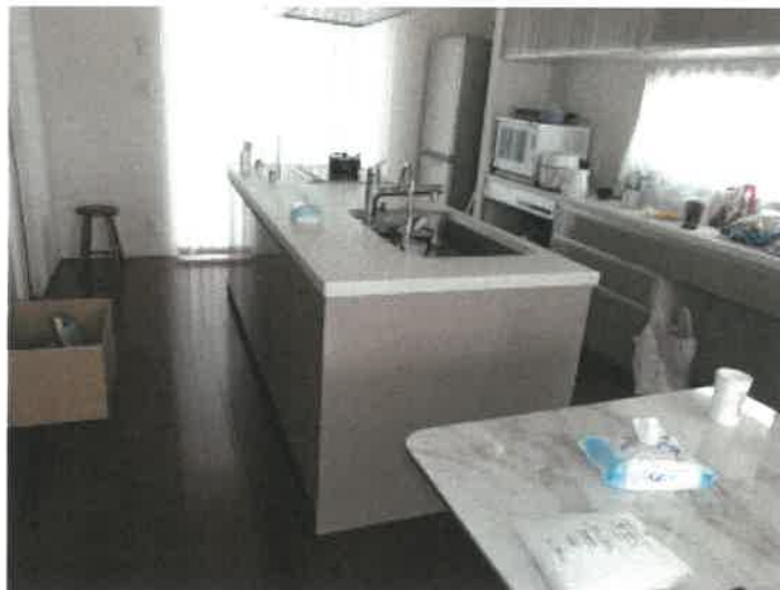
物件4建物の1階キッチンの状況
