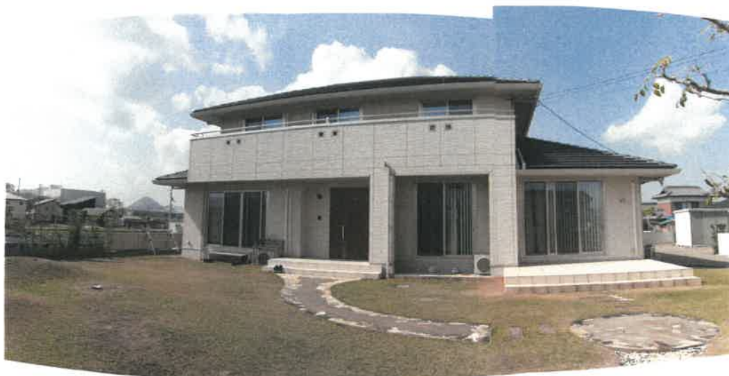
物件 4 建物の南側の状況
