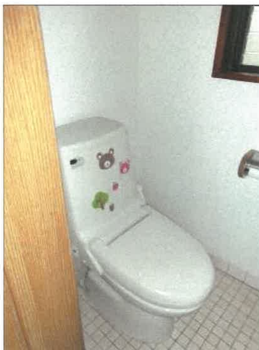
物件 2 建物の 1 階トイレの状況
