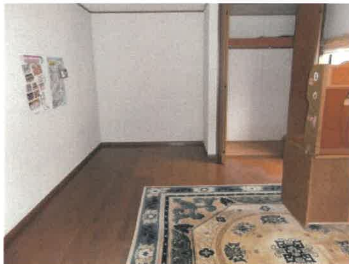
物件 2 建物の 2 階北端洋室の状況
