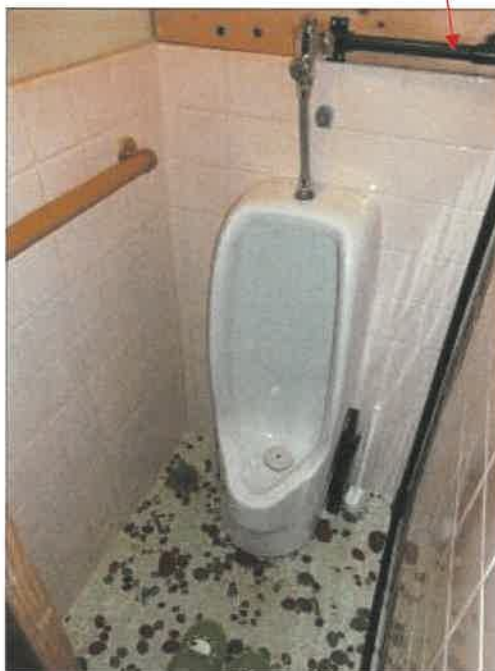
物件 3 主である建物トイレの状況
