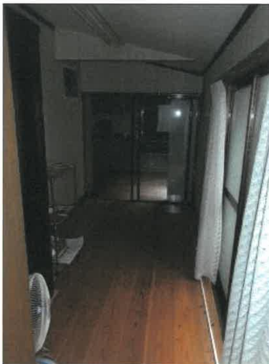
物件3主である建物北端ホール（廊下）部分の状況（増築部分）
