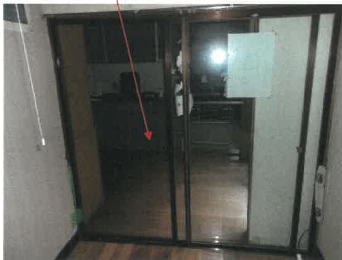
物件3主である建物北端ホール（廊下）部分の状況（増築部分）
