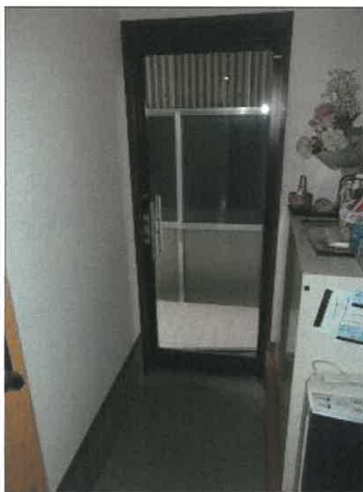
物件 2 建物の 1 階南端洋室からの南側出入口の状況
