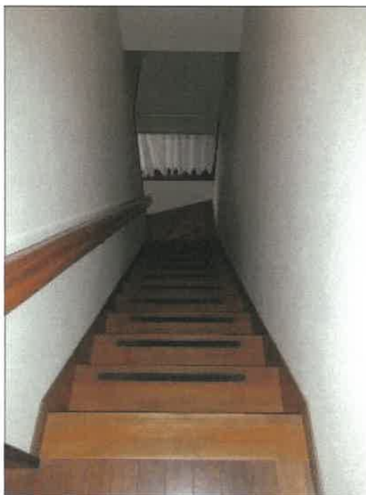
物件 2 建物の階段の状況
