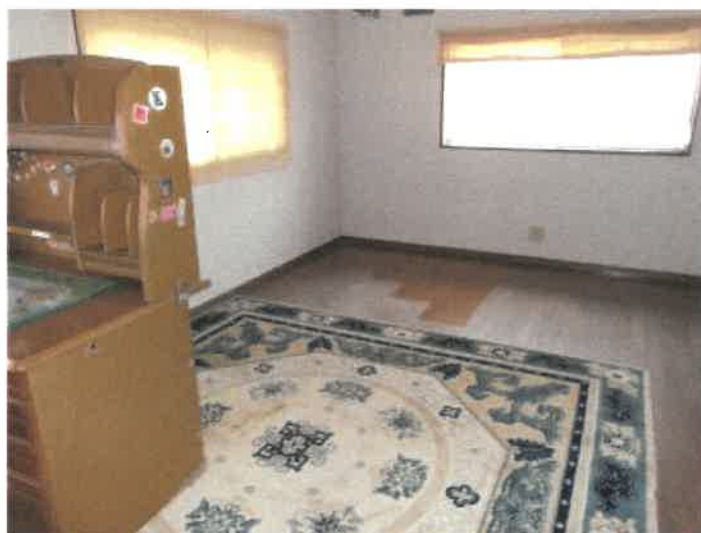
物件 2 建物の 2 階北端洋室の状況
