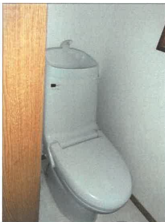
物件 2 建物の 2 階トイレの状況
