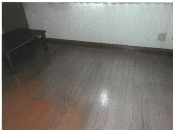
物件2建物の2階中の洋室の状況
