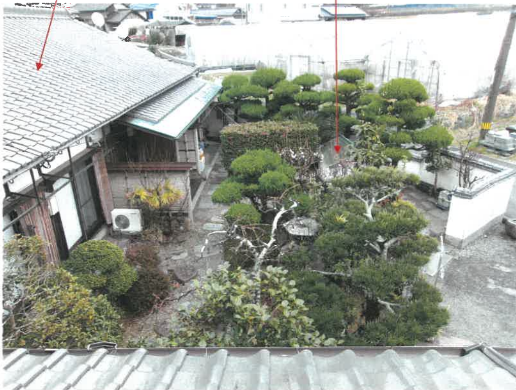
物件3建物の南東側庭の状況
