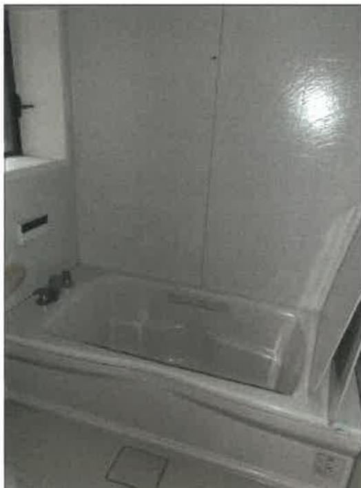
物件 2 建物の 1 階浴室の状況
