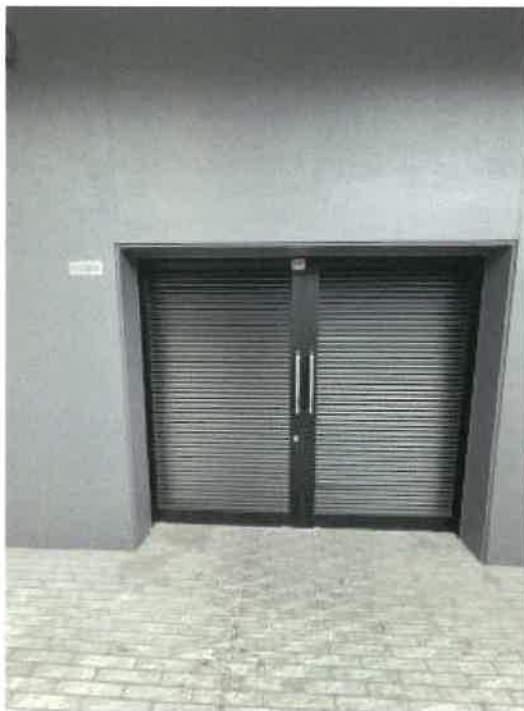
ゴミ置場の状況（施錠）
