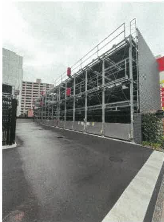
立体駐車場の状況
