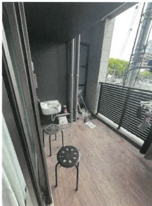
バルコニーの状況
