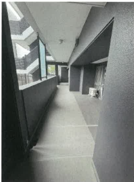
開放廊下の状況
