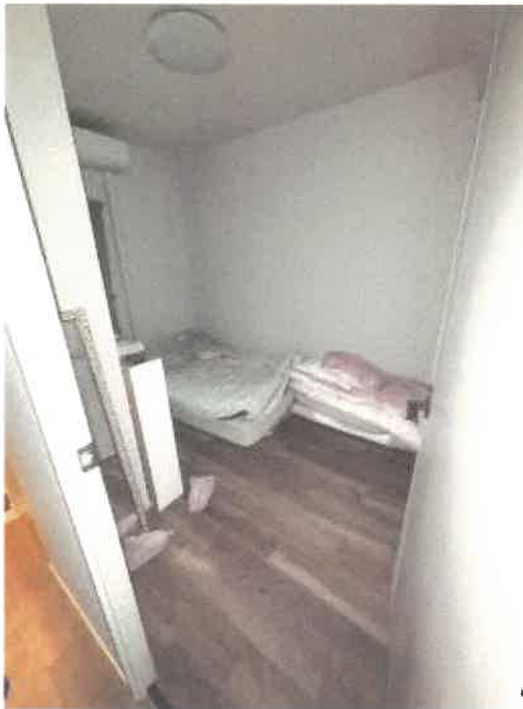
北東側洋室の状況
