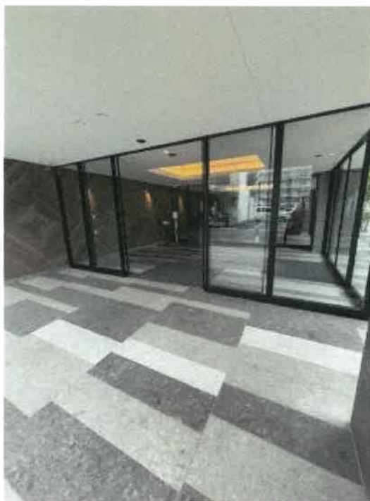
ポーチの状況
