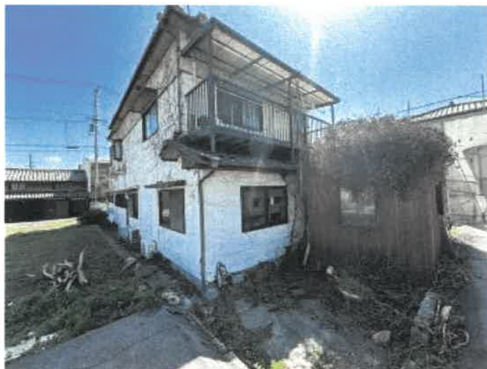
本件物件の南西側の状況
