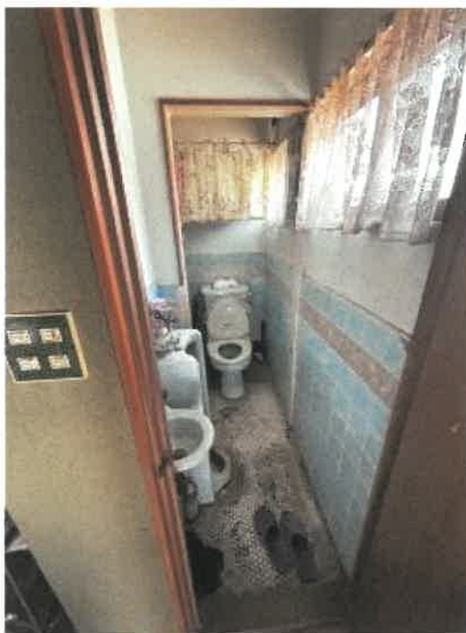
物件2 1階トイレの状況
