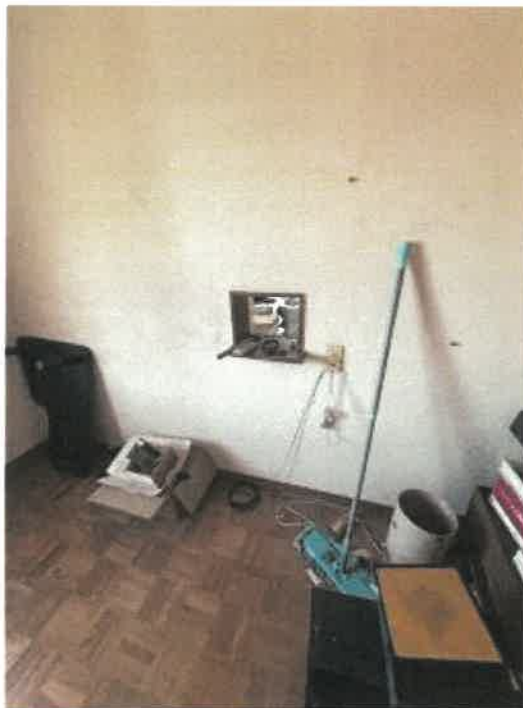
物件 2 2階北西側洋室と北側洋室の小窓の状況
