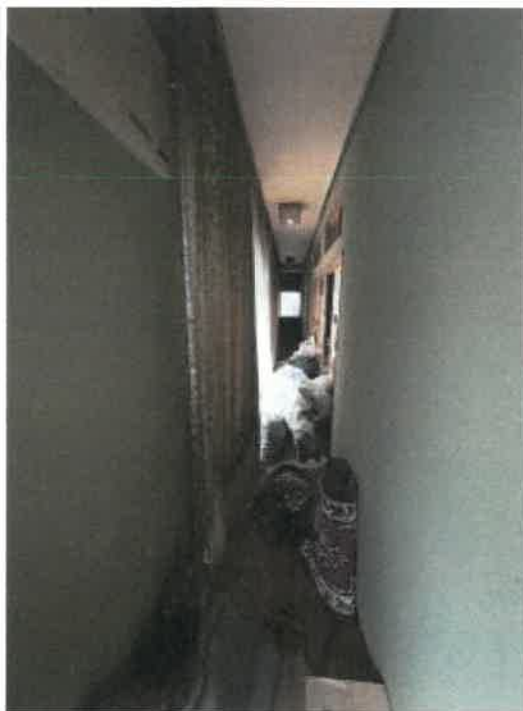
物件2 1階廊下の状況
