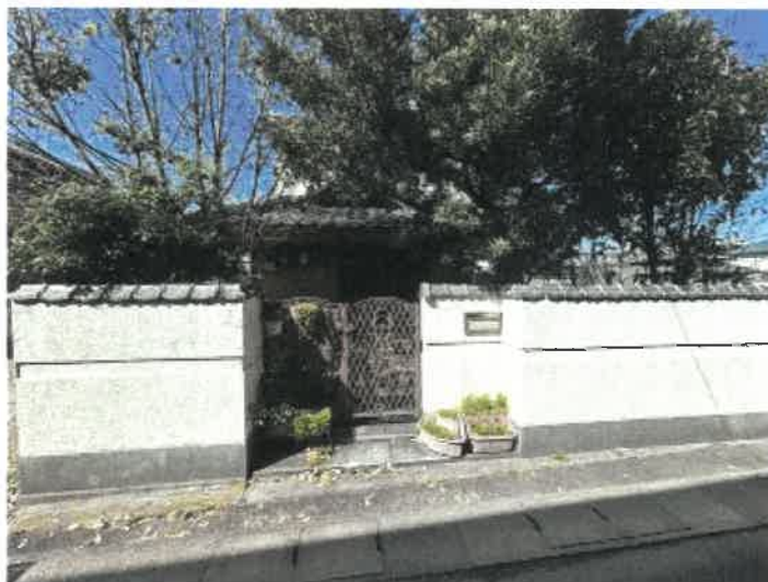
門扉付近の状況
