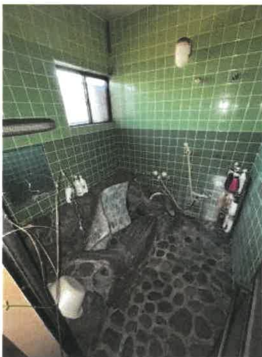
物件 2 1 階浴室の状況
