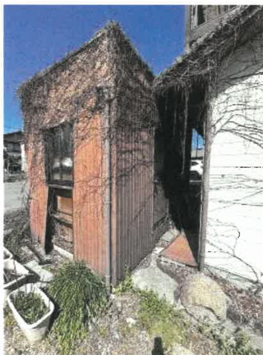
未登記附属建物の状況
