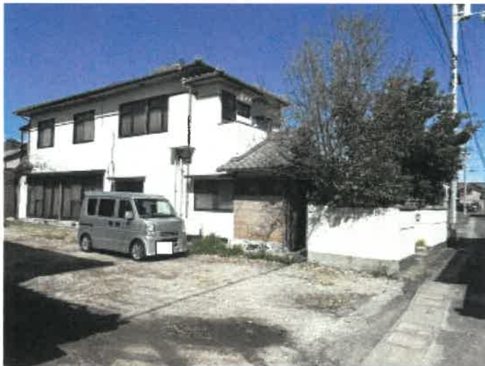
本件物件の南東側の状況
