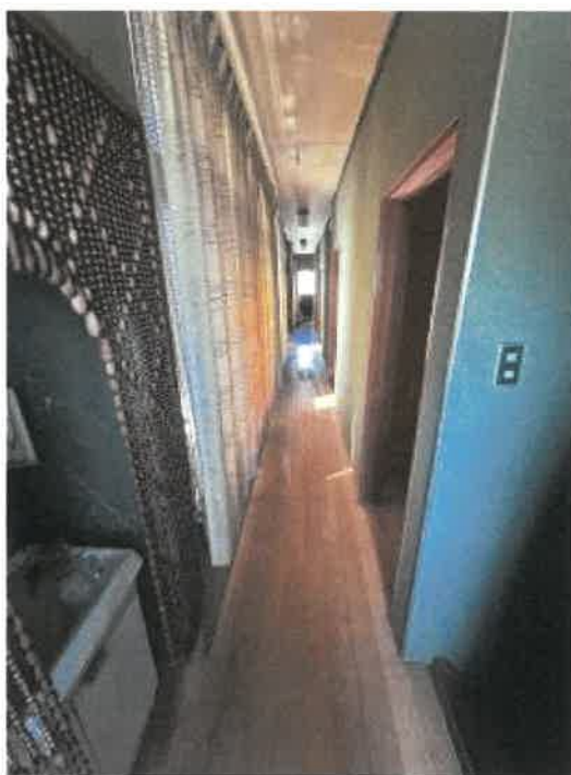
物件 2 2階廊下の状況
