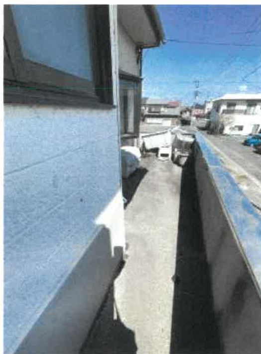
物件 2 2階ルーフバルコニーの状況
