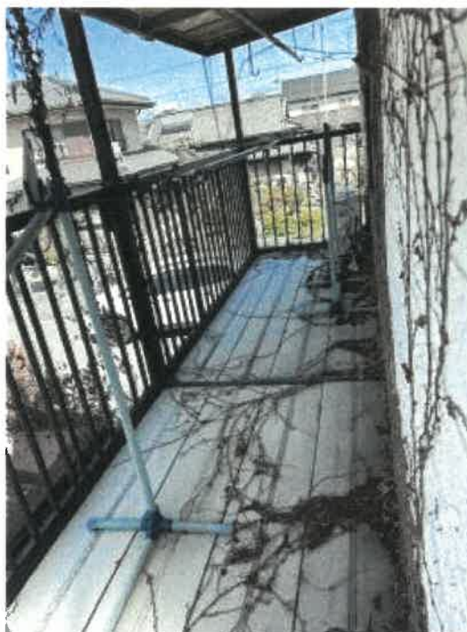
物件 2 2階ベランダの状況
