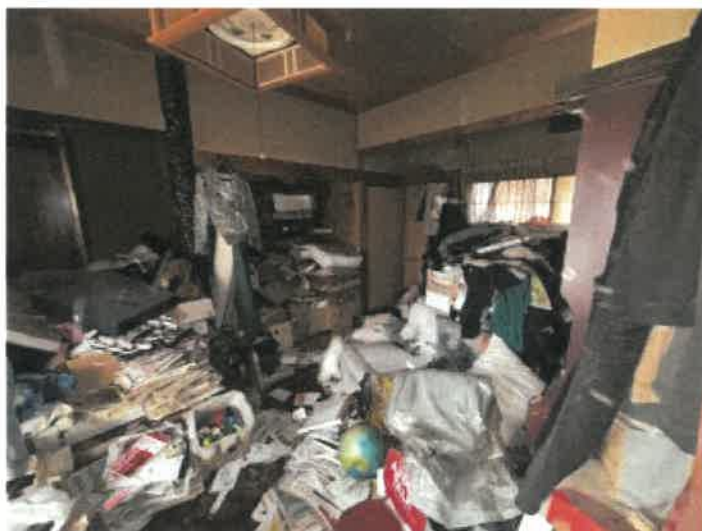
物件2 1階中央和室の状況
