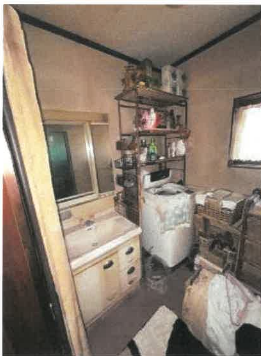
物件 2 1 階洗面所・脱衣所の状況
