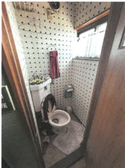
物件2 2階トイレの状況
