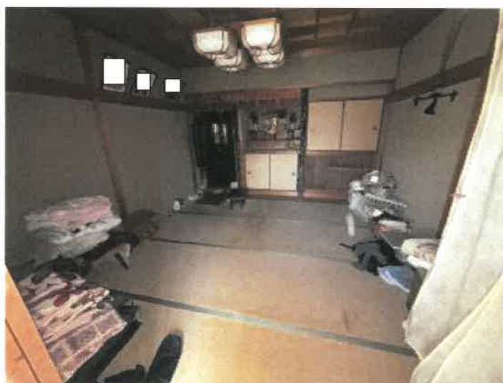
物件 2 2階和室の状況
