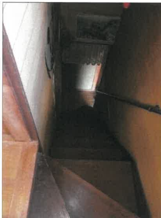
物件 2 建物の階段の状況
