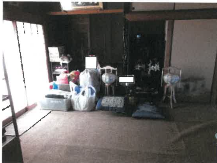
物件2建物の1階南東側西和室の状況
