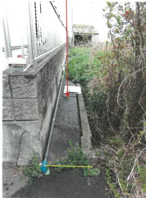
物件3 土地北東側、北西側及び南東側境界付近の状況
