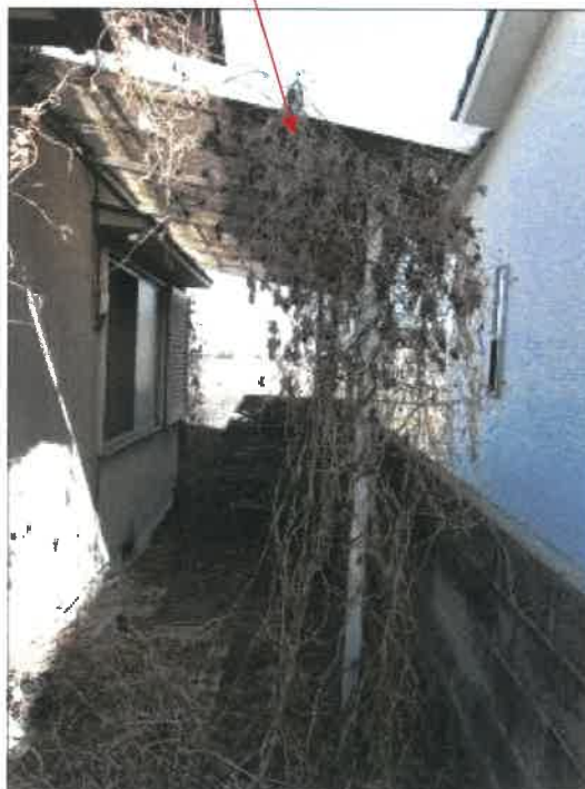
物件 2 建物北東側の状況
