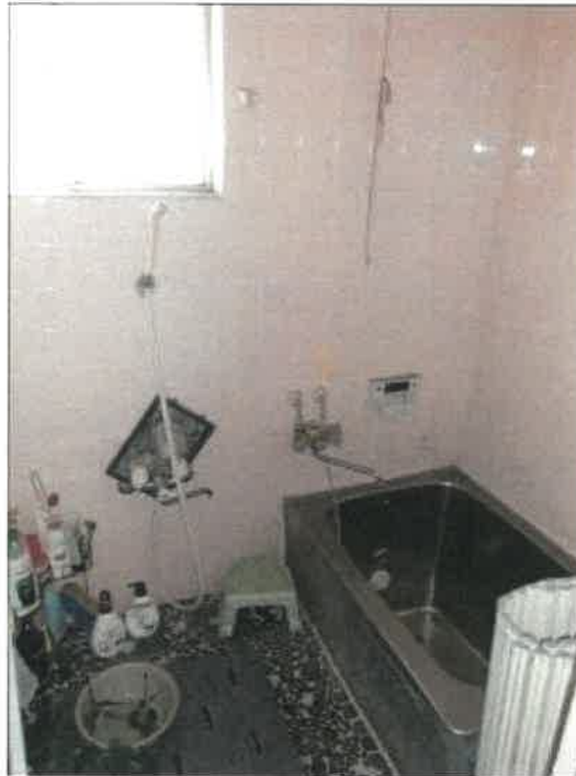
物件 2 建物の 1 階浴室の状況
