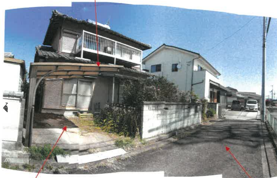
物件 1 土地南東側及び南西側境界付近， 並びに，物件 4 土地北東側，北西側及び南東側境界付近の状況 舗装私道（物件 4，建築基準法上の道路ではない）
