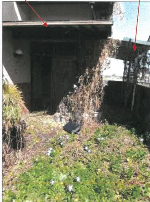
物件 2 建物玄関周りの状況
