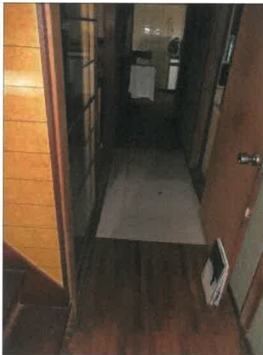
物件 2 建物の 1 階玄関前廊下の状況
