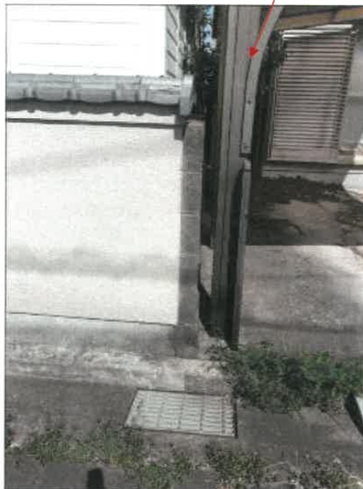
物件 1 土地南西側境界付近の状況
