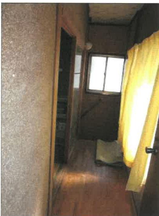
物件2建物の2階南北東側和室前廊下の状況
